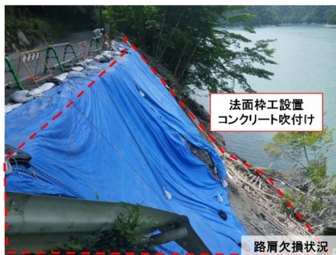
図 参①-4 路肩の欠損が確認された箇所の現況写真例
