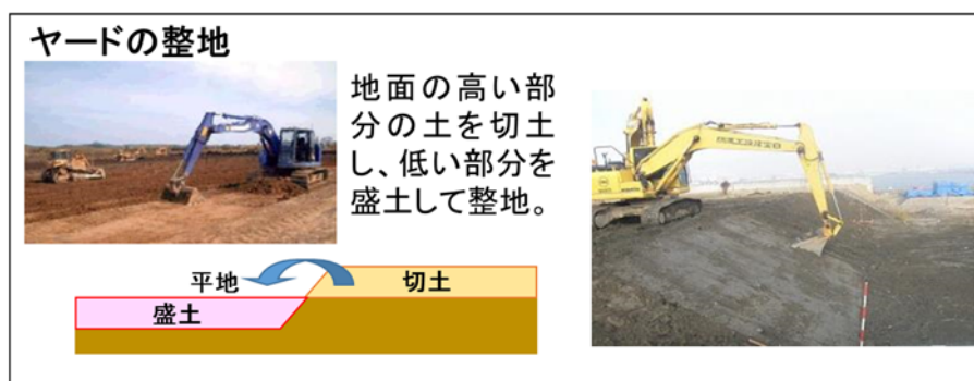
図 2-3 ヤード整地（写真は類似工事の例）
