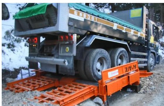
写真4-1-16 タイヤ洗浄機設置の状況（一例）
