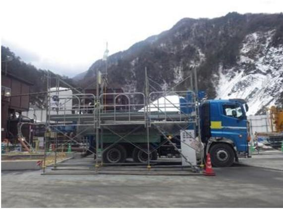
写真4-1-22 荷台への防塵シート敷設
