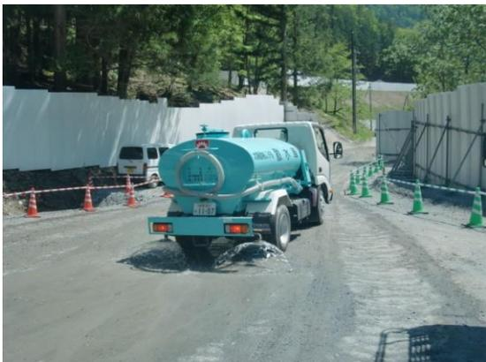
写真4-1-5 工事現場の散水状況
