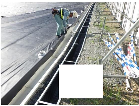
写真4-1-27 側溝設置状況（一例）
