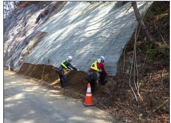
写真4-1-39 法面、斜面の保護、切土法面等の緑化による植生復元の状況（一例）
