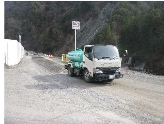
写真4-1-26 工事現場の散水状況（一例）
