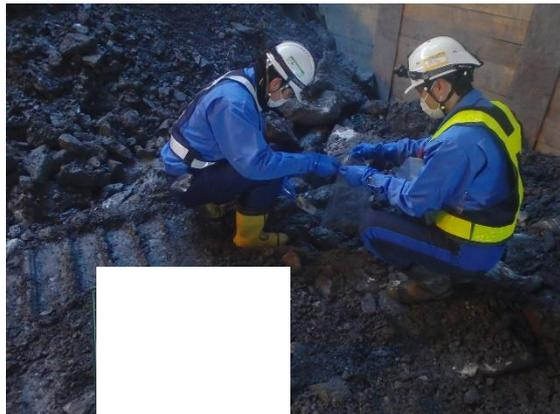
写真4-1-14 重金属等溶出試験試料採取の状況（一例）
