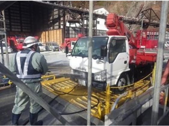
写真4-1-21 タイヤ洗浄の実施状況
