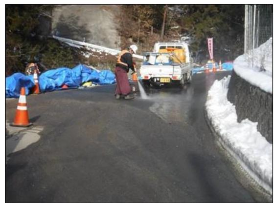
写真4-1-37 工事現場の散水状況（一例）
