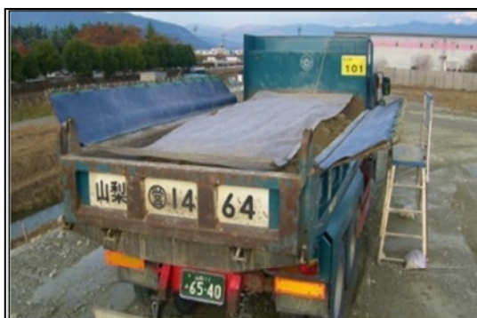
写真① 荷台への防塵シートの設置
