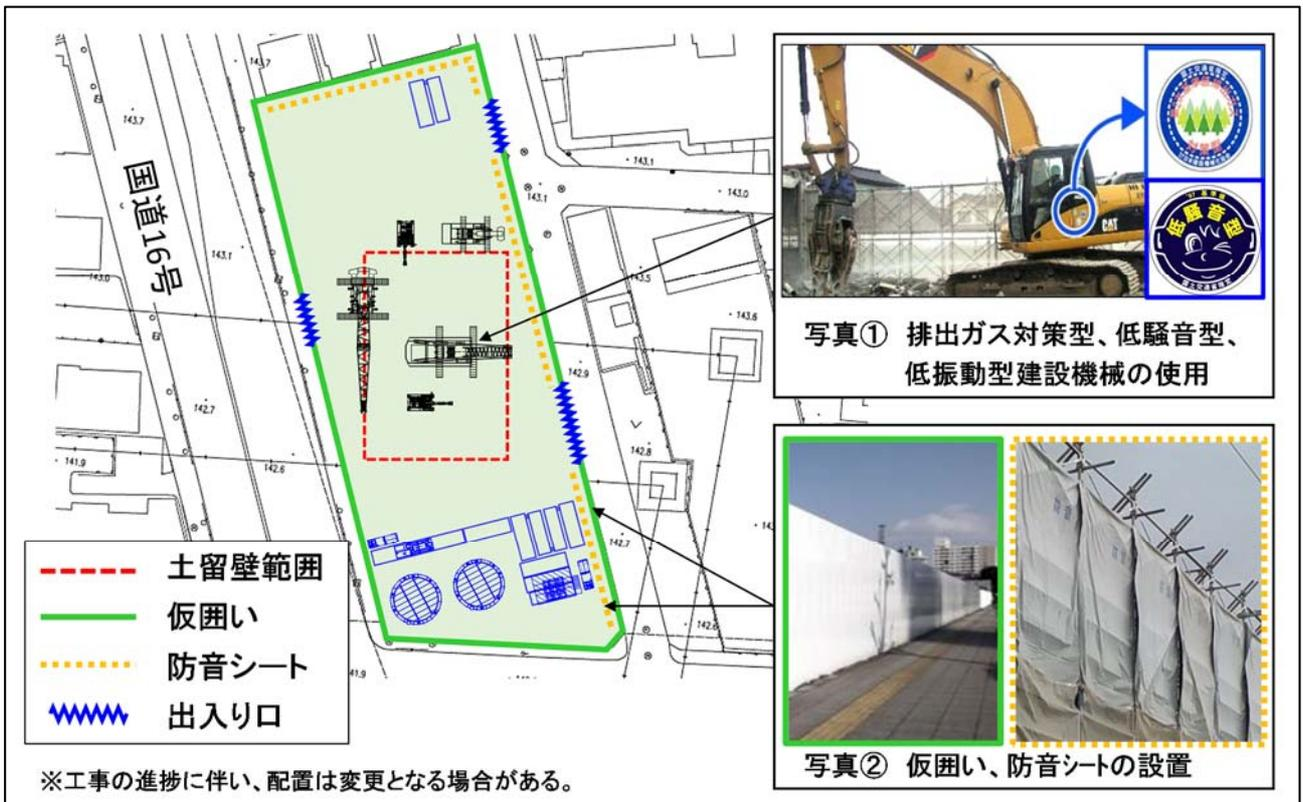
図 3-1 本工事の工事施工ヤードにおける大気環境に関する計画面の環境保全措置
