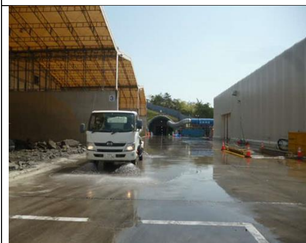
写真4-1-12-7 工事現場の清掃及び散水状況
