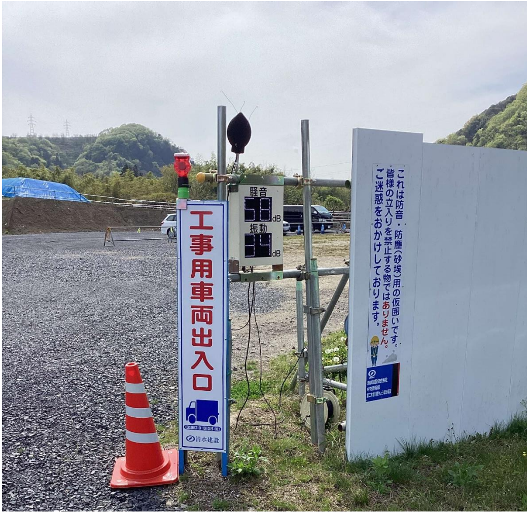
写真 参-3(5) モニター表示例 (03 第二木曾川橋りょう)
