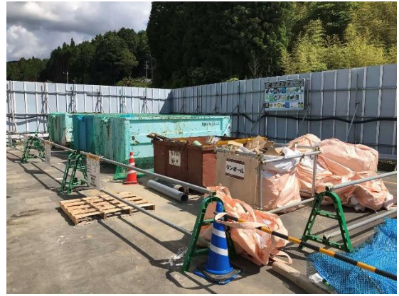
写真4-1-8-12 副産物の分別状況
