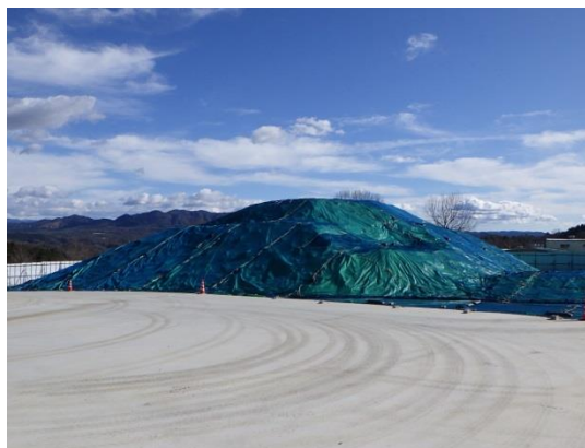
図 参 1-4-2 設備管理 (瑞浪市内土岐町発生土仮置き場)
