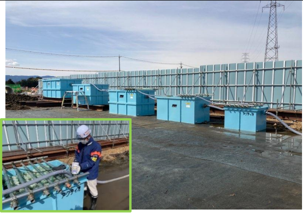
写真4-1-14-1-6 工事排水の適切な処理の 実施状況
