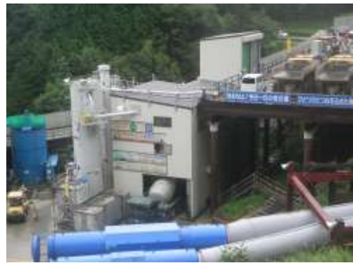
写真4-1-1-4 吹付コンクリートプラント における防音型建屋の設置状況
