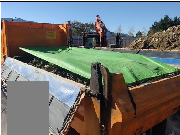
写真4-1-2-7 荷台への防じんシート敷設状況
