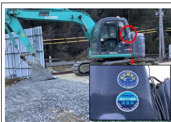
写真4-1-8-1 排出ガス対策型、低騒音型建設機械の使用状況
