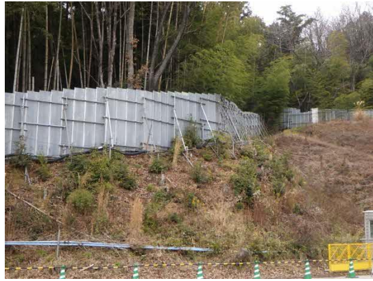
写真4-1-10-2 仮囲いの設置状況
