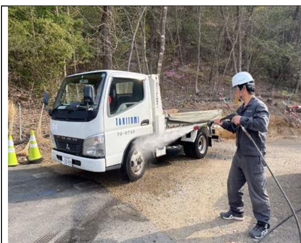
写真4-1-4-6 タイヤ洗浄の実施状況
