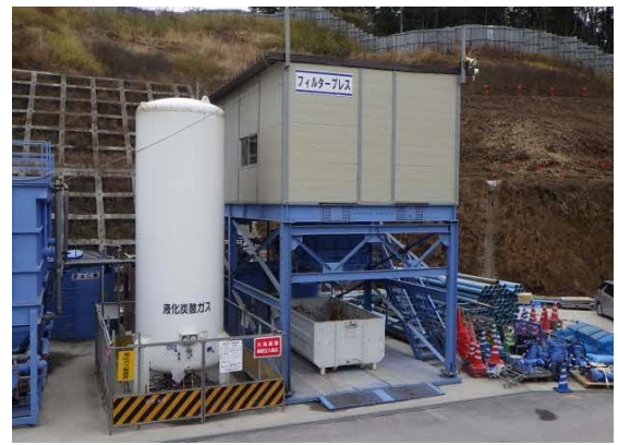
写真4-1-10-10 建設汚泥の脱水処理状況
