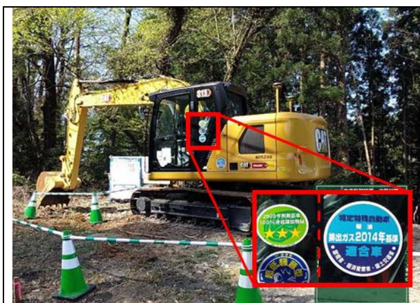
写真4-1-2-1 排出ガス対策型、低騒音型建設機械の稼働
