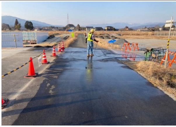
写真4-1-14-1-5 工事現場の清掃や散水の 実施状況
