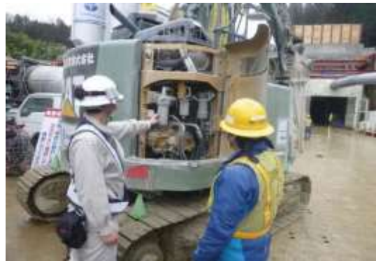
写真4-1-1-6 建設機械の 点検・整備実施状況
