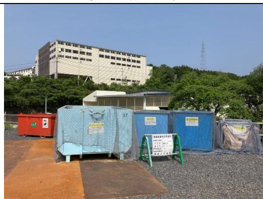
写真4-1-5-6 副産物の分別状況
