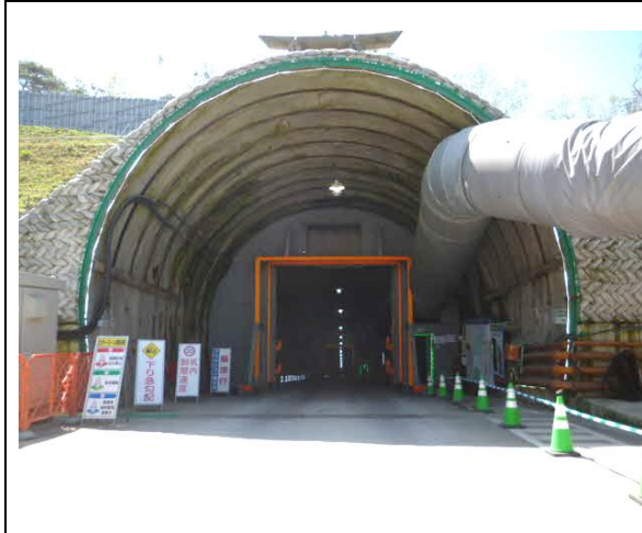
写真4-1-12-3 防音扉の設置状況
