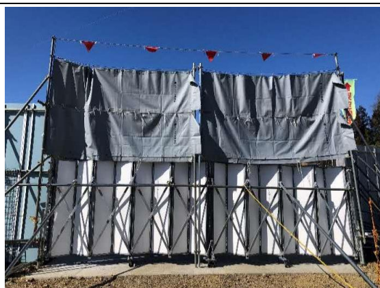
写真4-1-7-3 防音シートの設置状況
