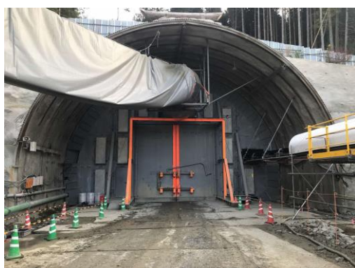
写真4-1-8-3 防音扉の設置状況
