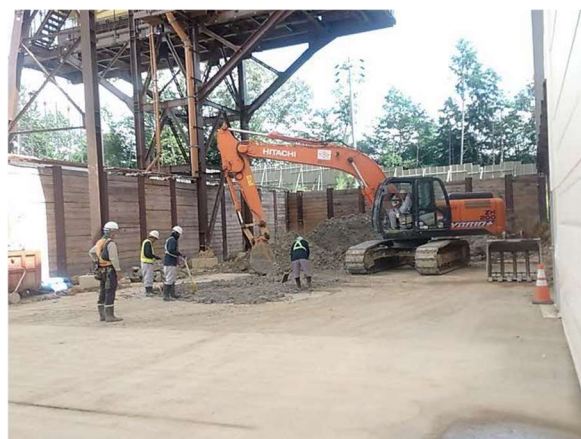
写真4-1-13-12 副産物(コンクリートがら) の分別状況
