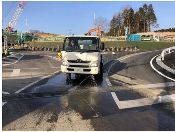
写真4-1-7-6 工事現場の清掃及び散水状況
