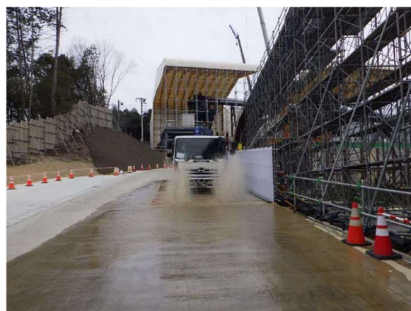
写真4-1-13-10 タイヤ洗浄の実施状況
