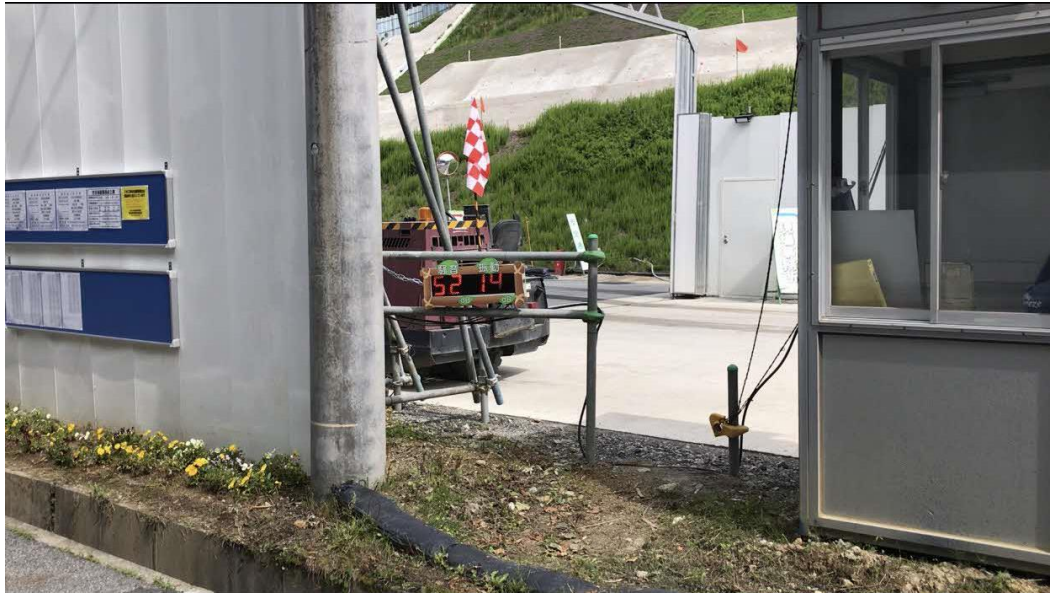
写真 参-3(3) モニター表示例 (02 瀬戸非常口)
