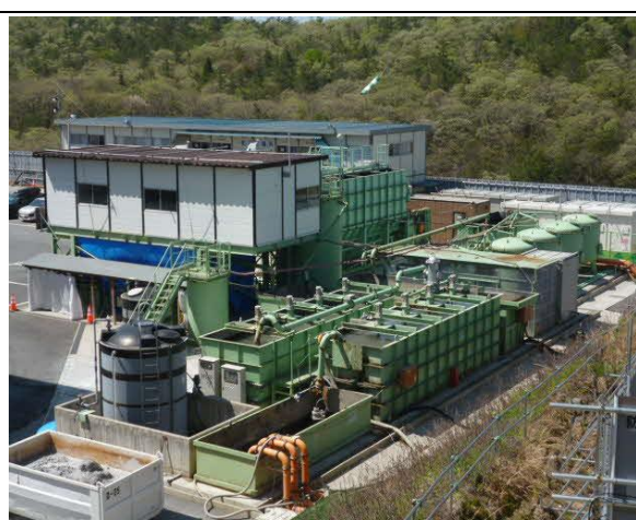
写真4-1-12-8 濁水処理設備設置状況
