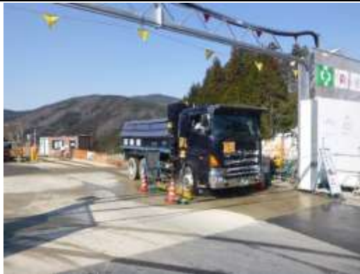
写真4-1-1-10 タイヤ洗浄の実施状況
