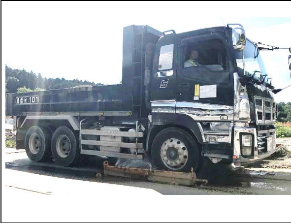
写真4-1-8-11 タイヤ洗浄の実施状況
