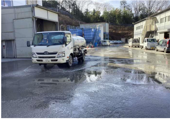
写真4-1-10-7 工事現場の清掃及び散水状況
