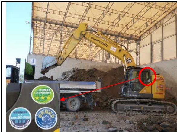
写真4-1-12-1 排出ガス対策型、低騒音型建設機械の使用状況
