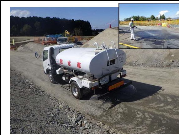
写真4-1-6-5 工事現場の散水の 実施状況
