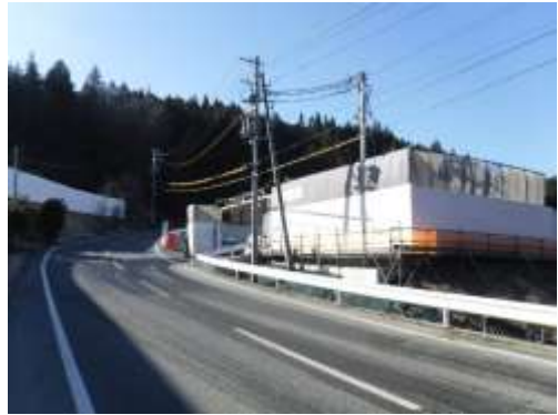
写真4-1-1-2 仮囲いの設置状況
