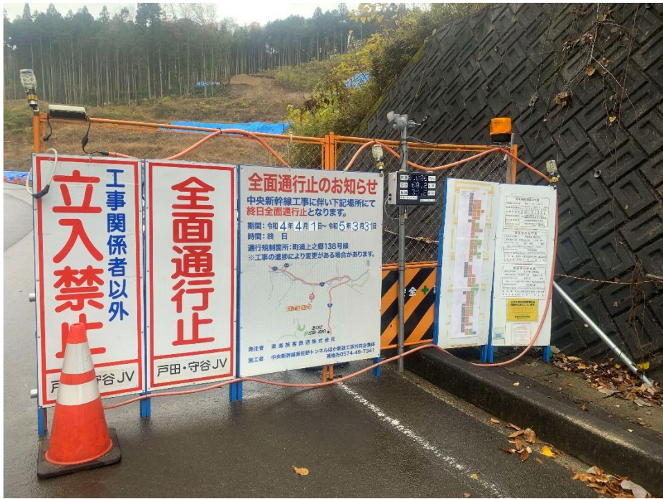
写真 参-3(14) モニター表示例 (09 美佐野工事施工ヤード)
