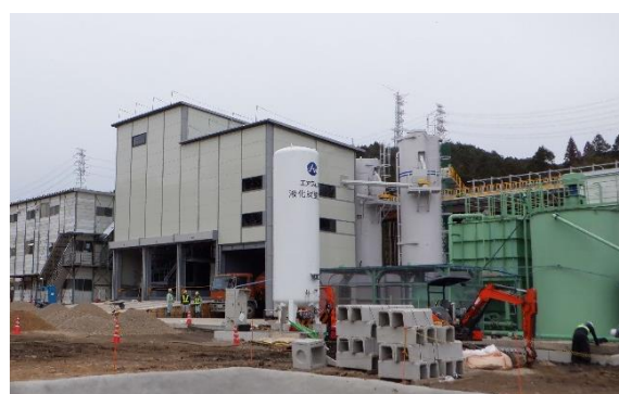
写真4-1-8-4 防音型吹付プラントの設置状況
