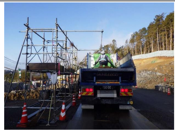
写真4-1-3-9 荷台への防じんシート敷設状況
