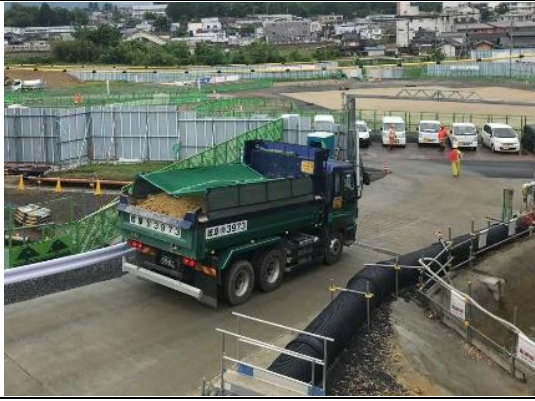
写真4-1-5-7 荷台への防じんシート敷設状況
