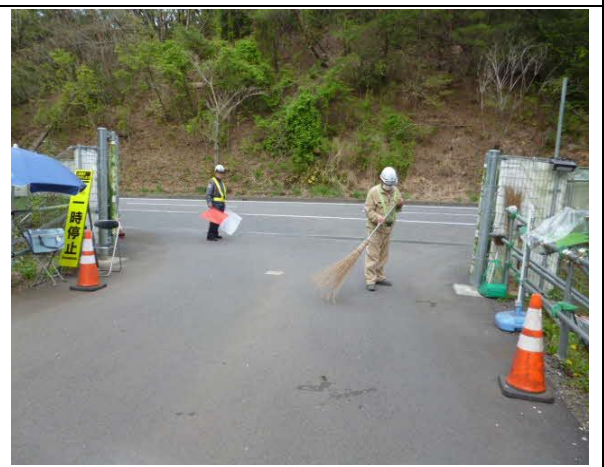
写真4-1-12-14 車両の出入り口の清掃状況
