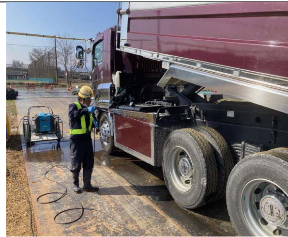
写真4-1-14-1-7 タイヤ洗浄の実施状況
