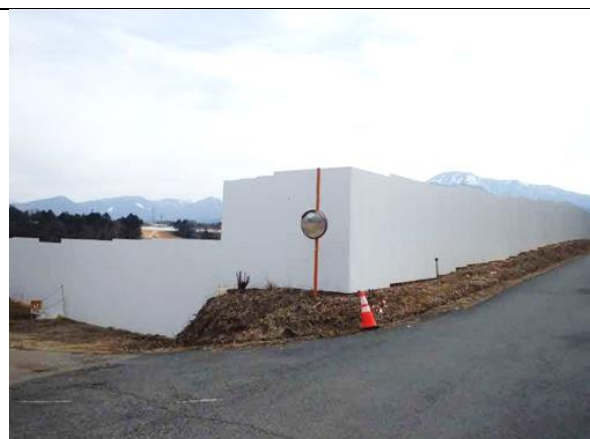
写真4-1-6-2 仮囲いの設置状況
