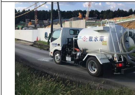
写真4-1-5-5 周辺道路の清掃及び散水状況
