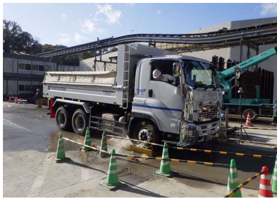
写真4-1-10-9 タイヤ洗浄の実施状況
