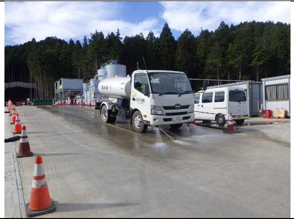
写真4-1-13-14 車両の出入り口等の清掃状況
