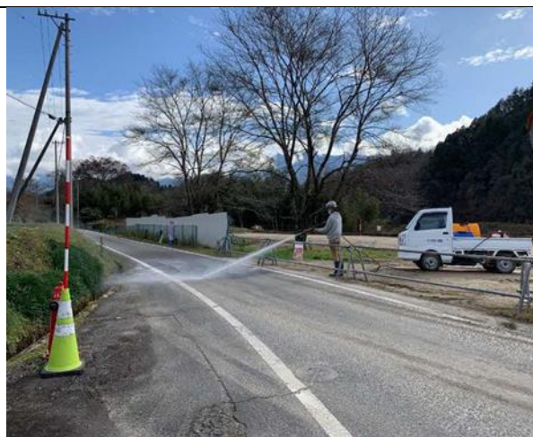
写真4-1-4-5 周辺道路での散水状況
