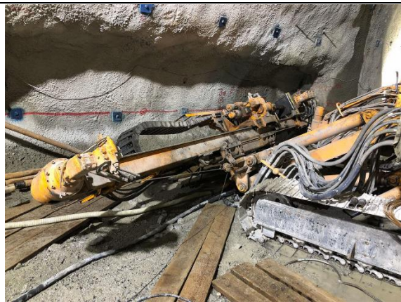
写真4-1-3-12 先進ボーリングの実施状況
