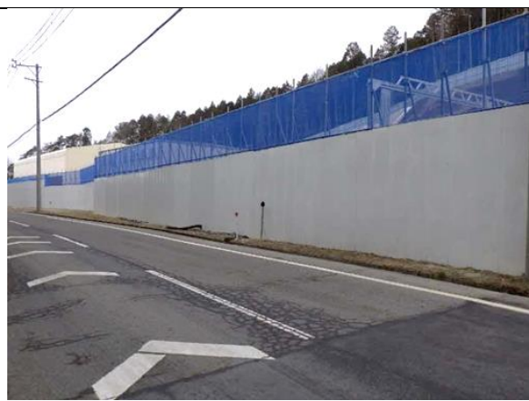
写真4-1-3-2 仮囲いの設置状況
