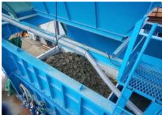
写真4-1-1-11 建設汚泥の脱水処理状況
