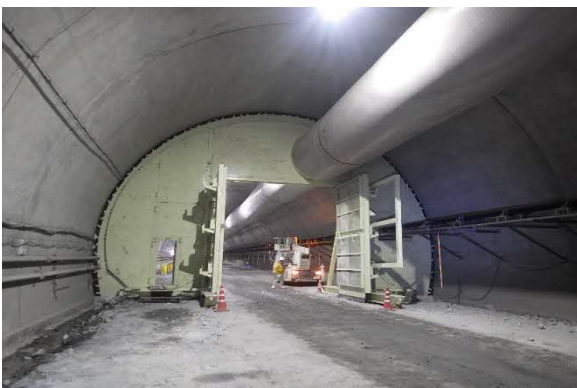
写真4-1-10-3 防音扉の設置状況
