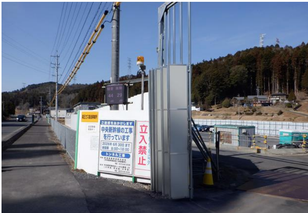
写真 参-3(11) モニター表示例 (07 長島トンネル、藤川高架橋)
