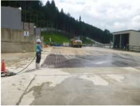
写真4-1-1-7 工事現場の 清掃及び散水状況
