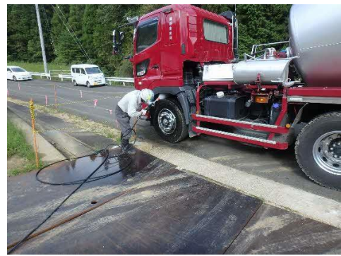
写真4-1-11-6 タイヤ洗浄の実施状況
