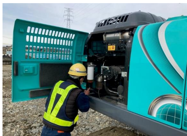
写真4-1-14-1-4 建設機械の点検及び整備による性能維持の実施状況
