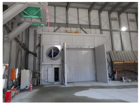
写真4-1-3-10 防音扉の設置状況
