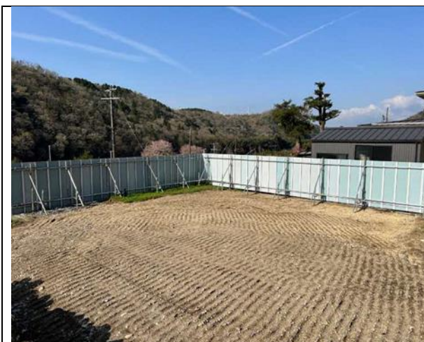
写真4-1-4-2 仮囲いの設置状況
