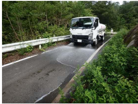
写真4-1-11-4 周辺道路の 清掃及び散水状況
