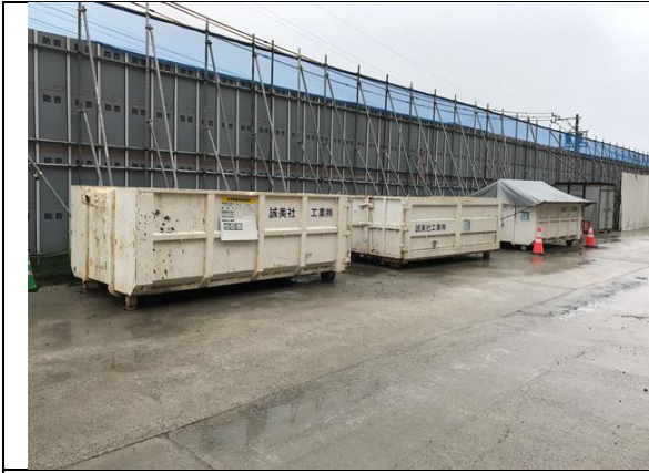
写真4-1-3-13 副産物の分別状況
