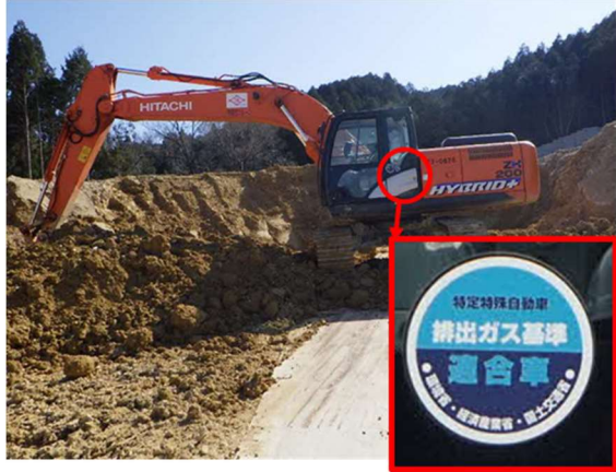
写真4-1-13-1 排出ガス対策型、 低騒音型建設機械の使用状況
