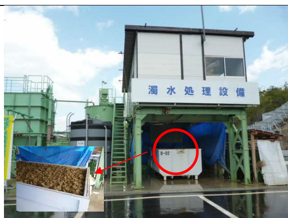
写真4-1-12-10 建設汚泥の脱水処理状況
