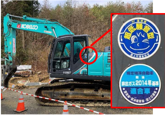
写真4-1-11-1 排出ガス対策型、 低騒音型建設機械の稼働
