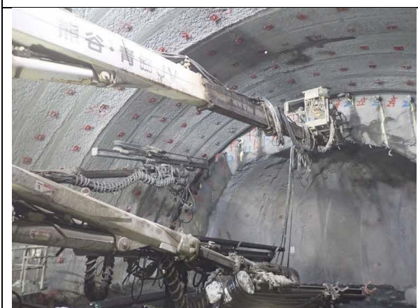
写真4-1-12-9 先行支保工 (フォアパイリング) の実施状況
