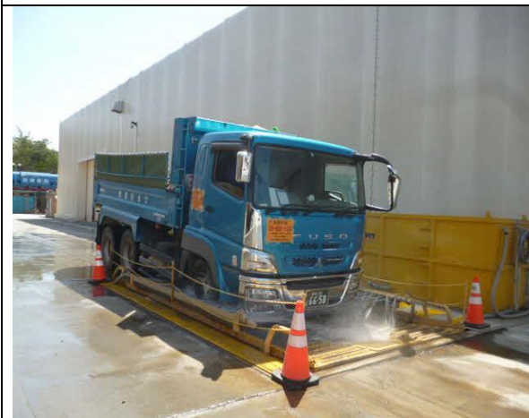
写真4-1-12-13 タイヤ洗浄の実施状況
