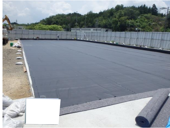
写真4-1-15-2-2 底面における 遮水シートの設置状況
