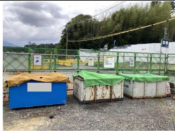
写真4-1-7-8 副産物の分別状況
