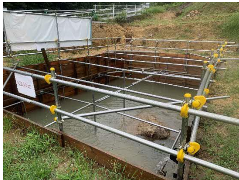
写真4-1-11-5 仮設沈砂池の設置状況
