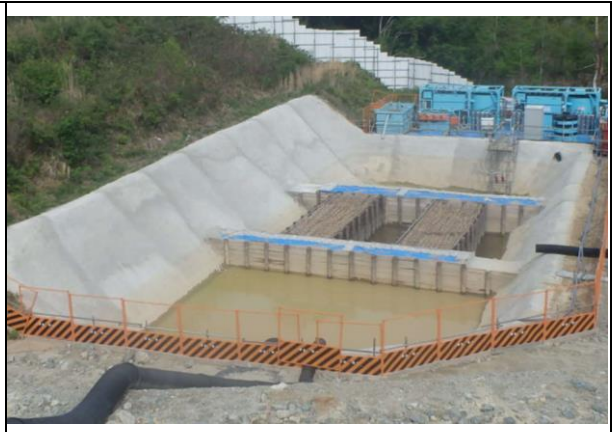
写真4-1-6-6 仮沈砂池・濁水処理施設の 設置状況
