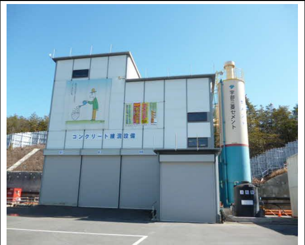
写真4-1-12-4 吹付コンクリートプラントにおける防音型建屋の設置状況
