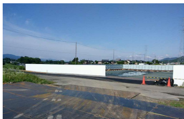
写真4-1-14-1-2 仮囲いの実施状況
