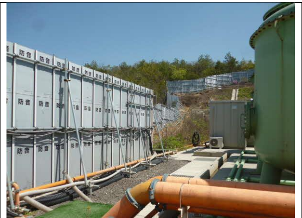
写真4-1-12-2 仮囲いの設置状況
