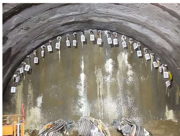
写真4-1-13-9 先行支保工 (フォアパイリング) の実施状況
