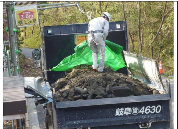
写真4-1-12-12 荷台への防じんシートの敷設状況
