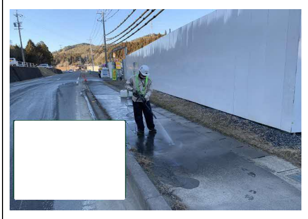
写真4-1-9-5 工事現場の散水状況
