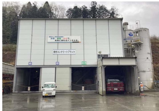
写真4-1-10-4 防音型建屋の設置状況
