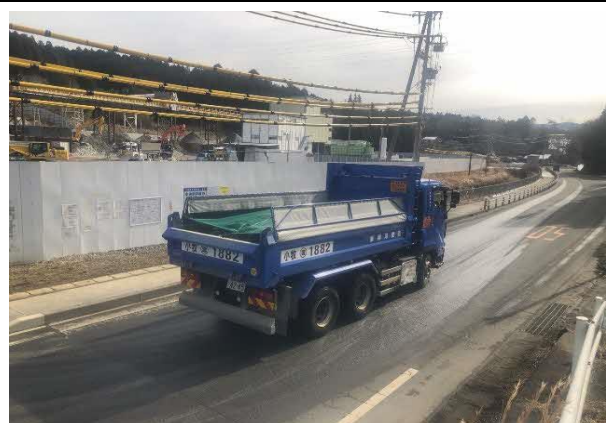
写真4-1-9-8 荷台への防じんシート敷設状況
