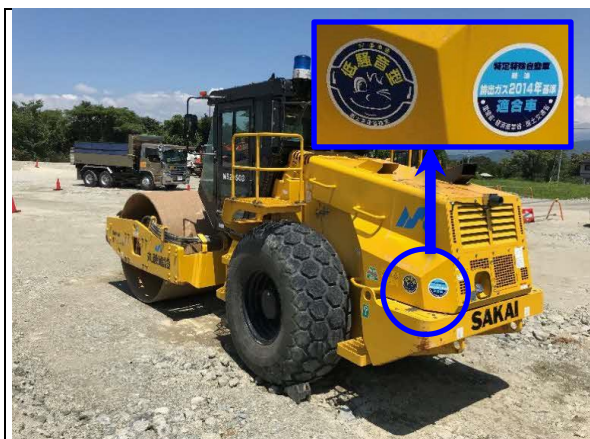
写真4-1-6-1 排出ガス対策型、低騒音型建設機械の稼働
