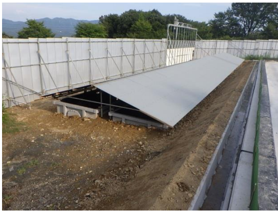
写真4-1-15-2-3 集水タンクの設置状況
