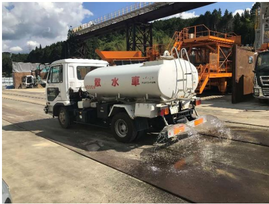
写真4-1-8-7 工事現場の清掃及び散水状況
