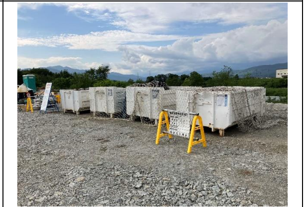
写真4-1-6-8 副産物の分別状況
