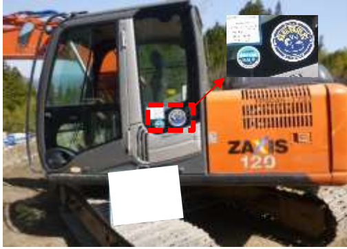
写真4-1-1-1 排出ガス対策型、 低騒音型建設機械の使用状況
