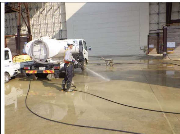
写真4-1-13-7 工事現場の清掃及び散水状況
