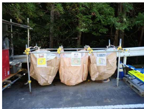
写真4-1-11-7 副産物の分別状況
