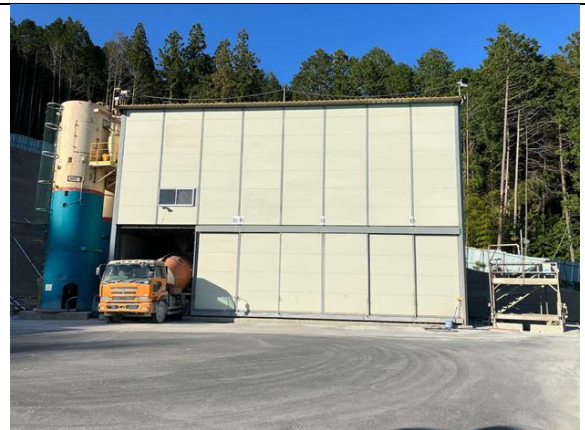
写真4-1-3-11 防音型建屋の設置状況
