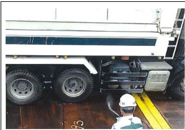
写真4-1-2-5 タイヤ洗浄の実施状況
