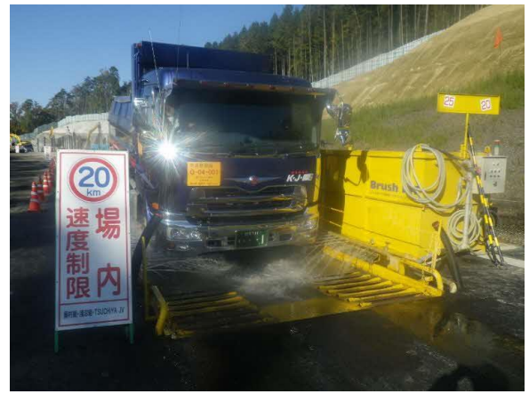
写真4-1-3-8 タイヤ洗浄の実施状況
