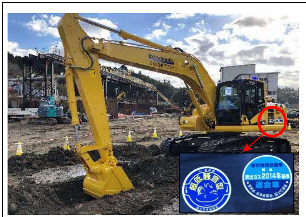
写真4-1-9-1 排出ガス対策型、 低騒音型建設機械の稼働
