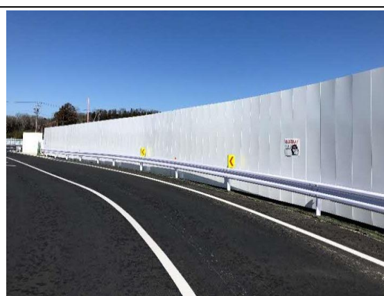
写真4-1-7-2 仮囲いの設置状況
