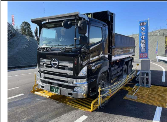
写真4-1-7-7 タイヤ洗浄の実施状況
