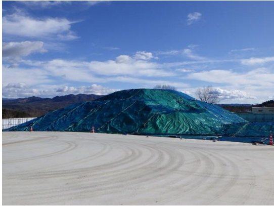
写真4-1-15-2-1 区分土への 遮水シート等の敷設状況
