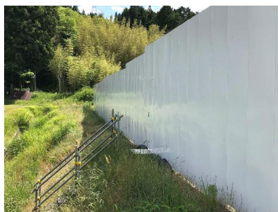
写真4-1-8-2 仮囲いの設置状況
