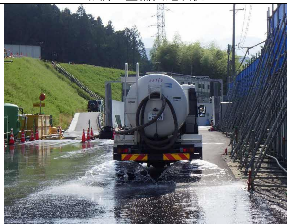
写真4-1-3-5 工事現場の 清掃及び散水状況
