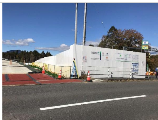
写真4-1-5-2 仮囲いの設置状況
