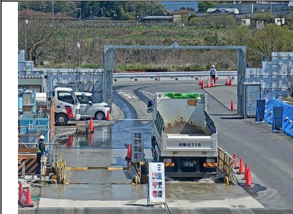
写真4-1-6-7 タイヤ洗浄の実施状況
