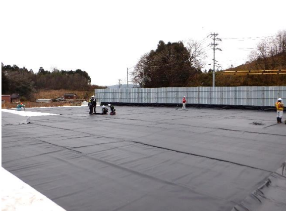
写真4-1-8-9 遮水型の土砂ピットにおける 遮水シートの設置状況
