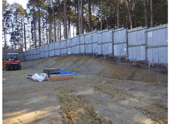
写真4-1-13-2 仮囲いの設置状況
