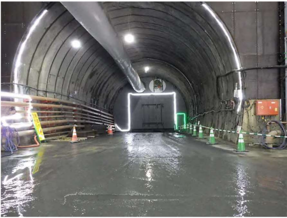
写真4-1-13-3 防音扉の設置状況
