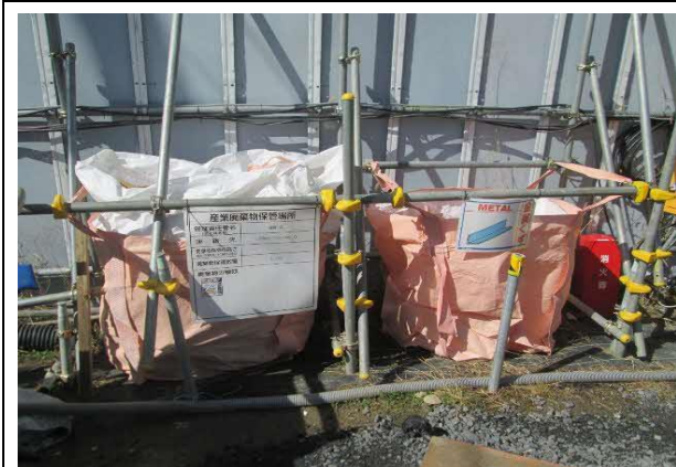
写真4-1-9-7 副産物の分別状況
