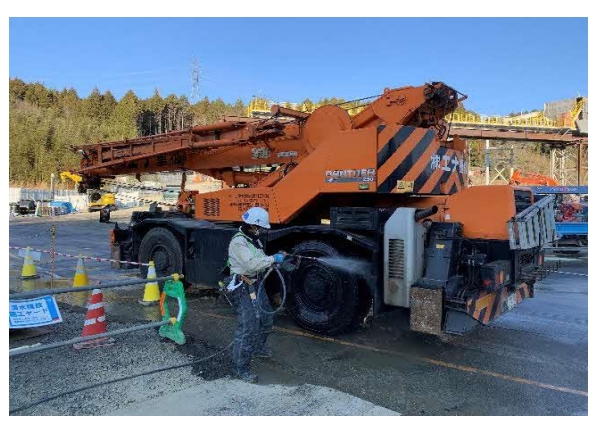
写真4-1-9-6 タイヤ洗浄の実施状況
