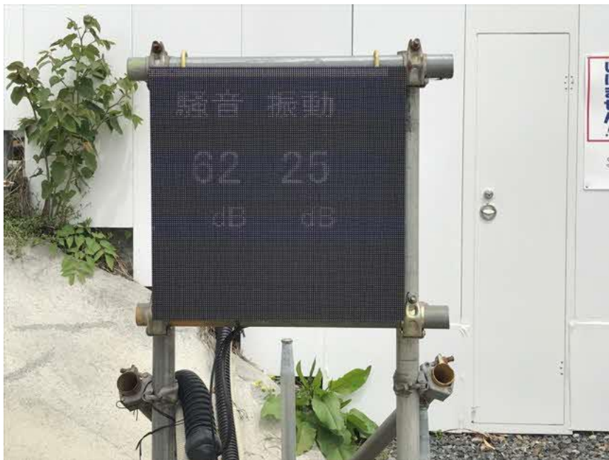
写真 参-3(9) モニター表示例 (05 駒場トンネル)
