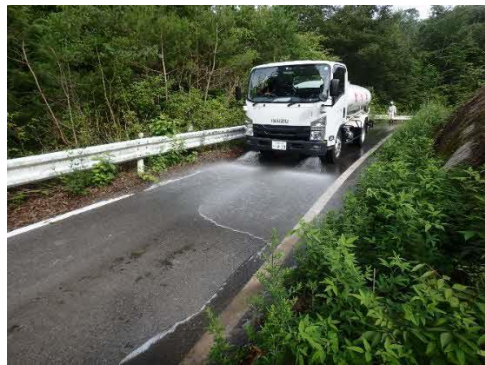
写真4-1-10-4 周辺道路の 清掃及び散水状況
