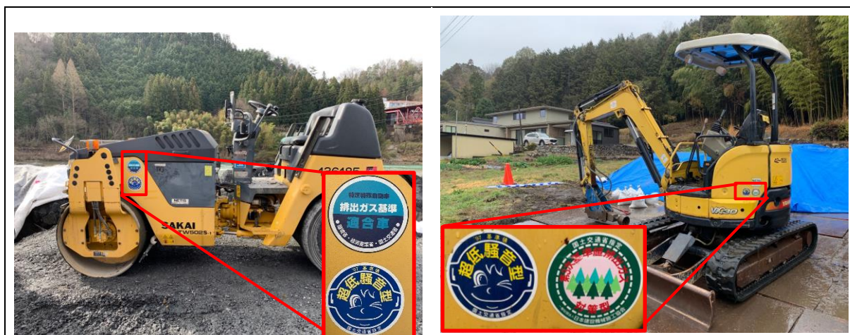
写真4-1-4-1 排出ガス対策型、低騒音型建設機械の稼働
