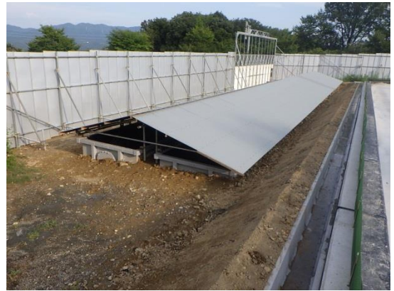
写真4-1-13-3-4 区分土への遮水シート等の 敷設状況
