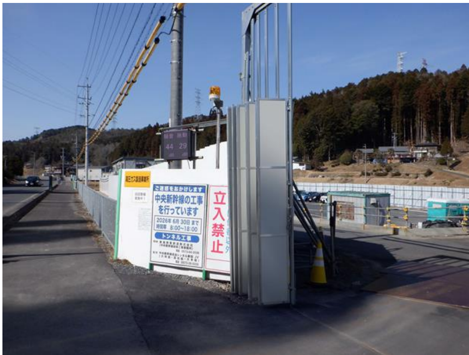
写真 参-2(5)-1 モニター表示例 (05 長島トンネル)
