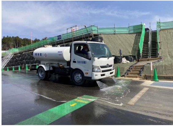
写真4-1-7-5 工事現場の清掃及び散水状況
