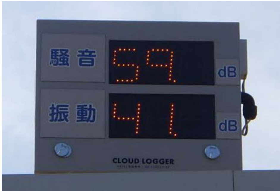
写真 参-2(8)-2 モニター表示例 (08 大針非常口)
