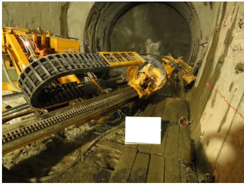
写真4-1-1-9 先進ボーリングによる 切羽前方の地質確認状況
