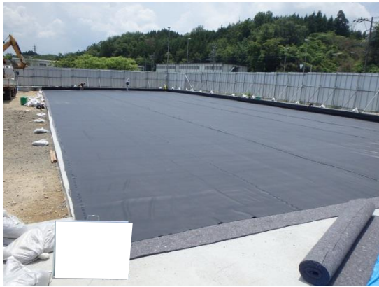
写真4-1-13-3-5 底面における遮水シートの 設置状況
