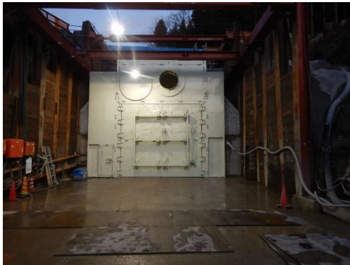
写真4-1-1-3 防音扉の設置状況
