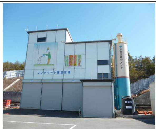
写真4-1-11-4 吹付コンクリートプラントに おける防音型の建屋の設置状況
