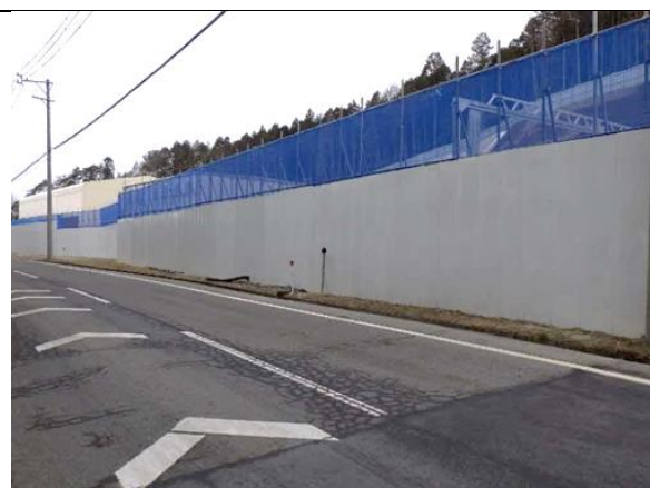
写真4-1-3-2 仮囲いの設置状況
