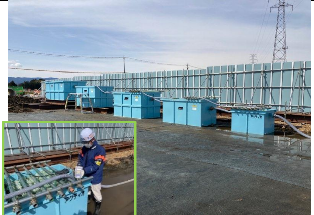
写真4-1-13-2-6 工事排水の適切な処理の 実施状況
