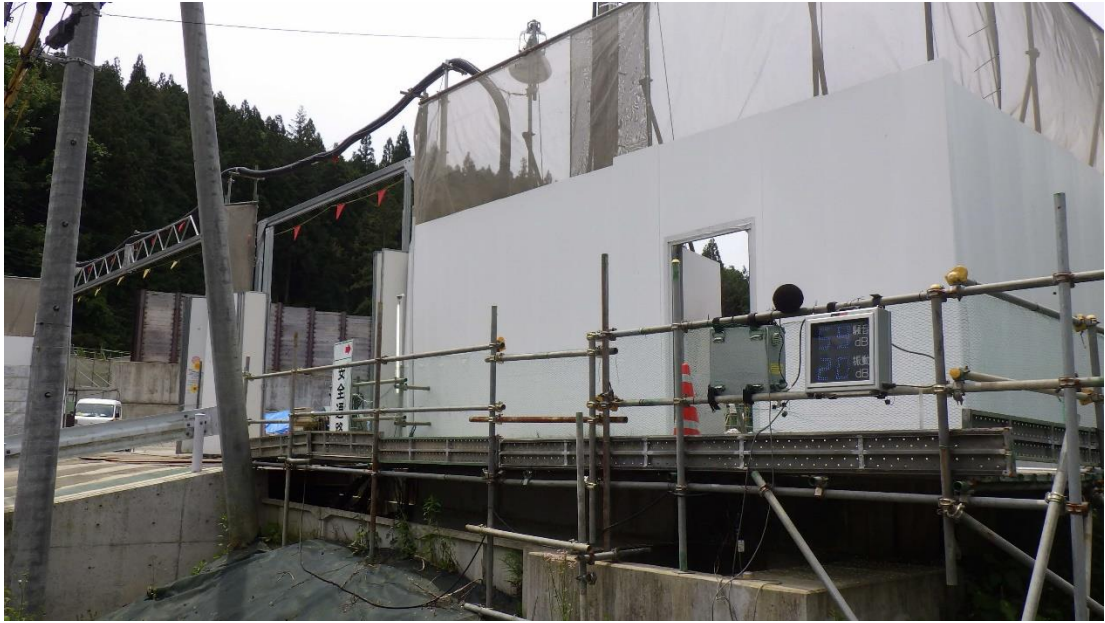
写真 参-2(1)-1 モニター表示例 (01 山口非常口)
