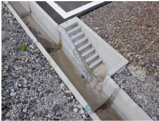
写真4-1-8-9 小動物等が脱出可能な スロープの設置状況
