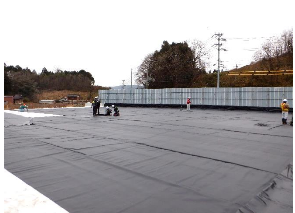
写真4-1-8-8 遮水型の土砂ピットにおける 遮水シートの設置状況
