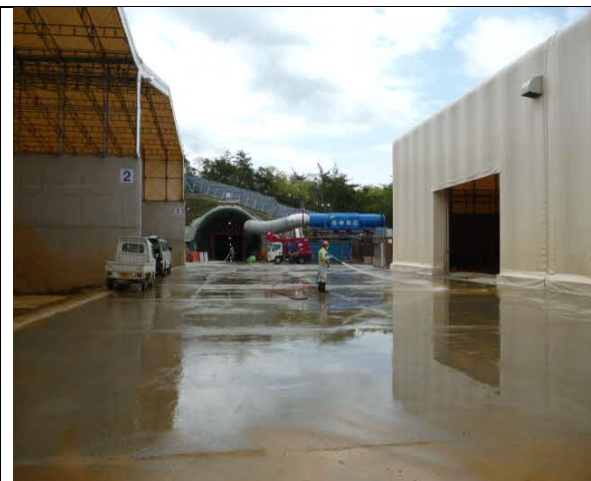
写真4-1-11-7 工事現場の清掃及び散水状況
