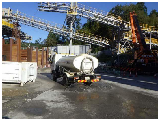
写真4-1-9-6 工事現場の 清掃及び散水状況
