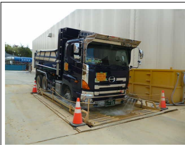
写真4-1-11-13 タイヤ洗浄の実施状況
