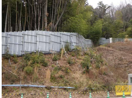
写真4-1-9-2 仮囲いの設置状況
