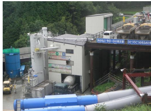
写真4-1-1-4 吹付コンクリートプラント における防音型の建屋の設置状況
