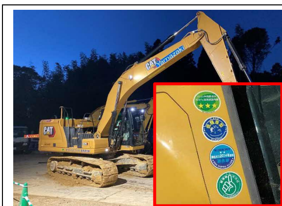
写真4-1-7-1 排出ガス対策型、 低騒音型建設機械の稼働
