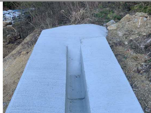
写真4-1-10-6 小動物等が脱出可能な スロープの設置状況
