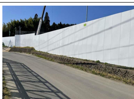
写真4-1-7-2 仮囲いの設置
