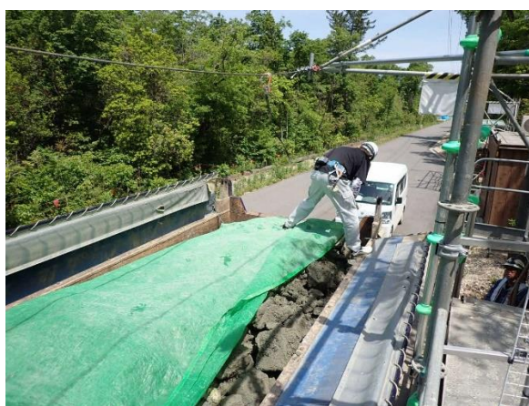
写真4-1-11-12 荷台への防じんシート敷設状況
