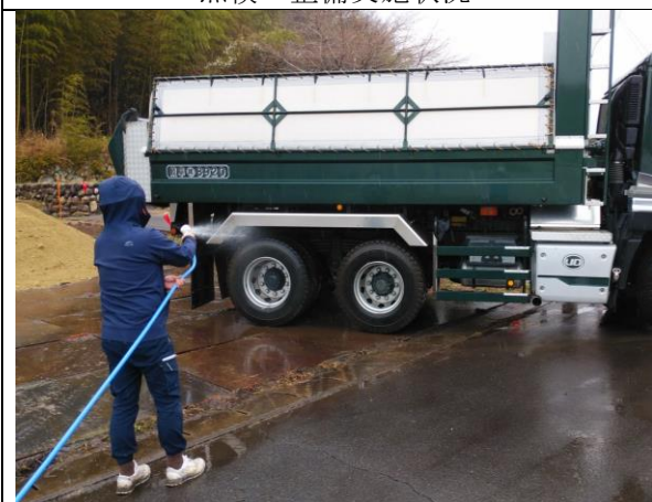
写真4-1-4-6 タイヤ洗浄の実施状況
