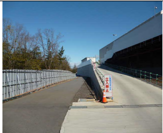
写真4-1-11-2 仮囲いの設置状況
