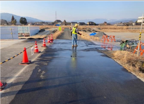
写真4-1-13-2-5 工事現場の清掃や散水の 実施状況
