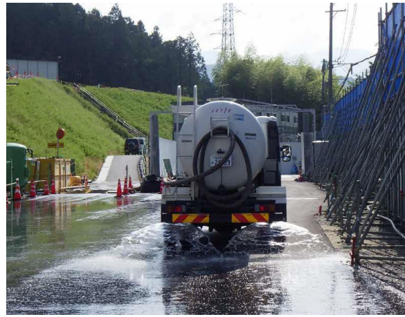
写真4-1-3-5 工事現場の 清掃及び散水状況
