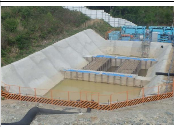
写真4-1-6-6 仮沈砂池・濁水処理施設の 設置状況
