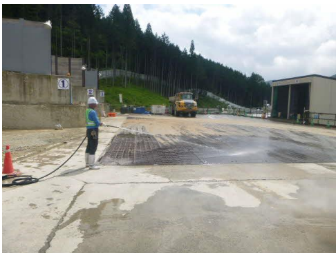
写真4-1-1-7 工事現場の 清掃及び散水状況
