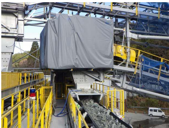
写真4-1-9-3 ベルトコンベア載替部の 防音シートの設置状況
