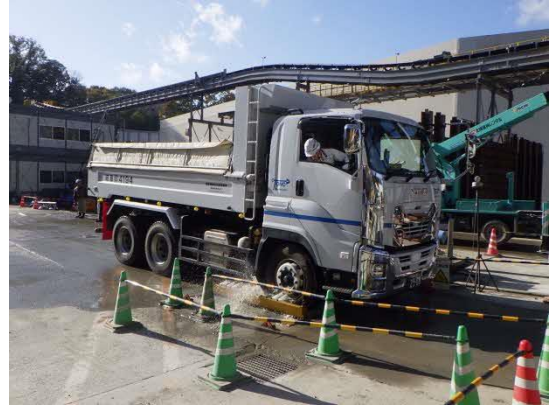
写真4-1-9-8 タイヤ洗浄の実施状況
