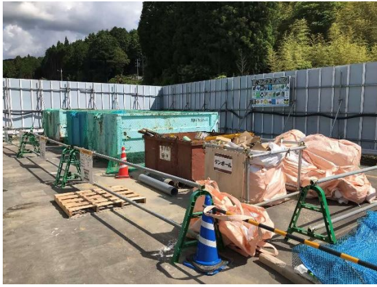
写真4-1-8-11 副産物の分別状況
