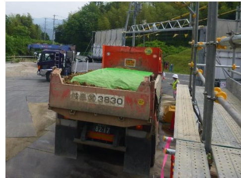
写真4-1-1-14 荷台への防じんシート敷設状 況
