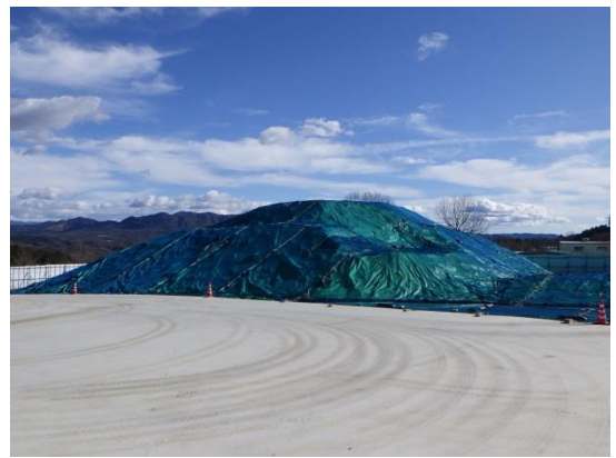
写真4-1-13-3-4 区分土への遮水シート等の 敷設状況
