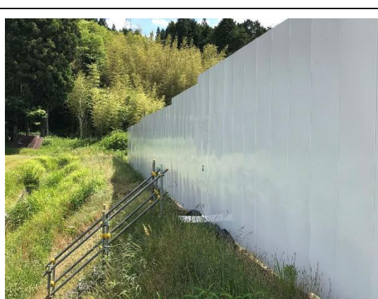
写真4-1-8-2 仮囲いの設置状況
