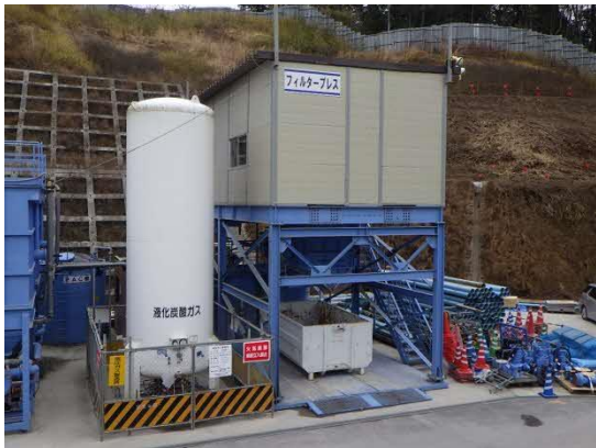
写真4-1-9-9 建設汚泥の脱水処理状況
