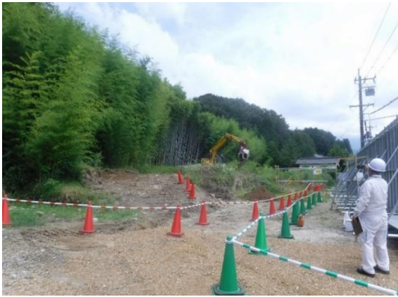
伐採作業の状況
