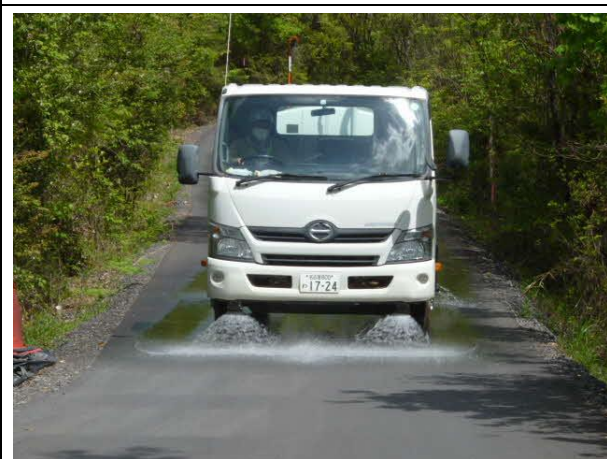
写真4-1-13-4-5 発生土仮置き場の 清掃及び散水の実施状況
