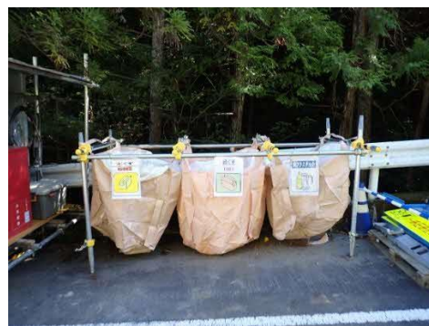
写真4-1-10-9 副産物の分別状況
