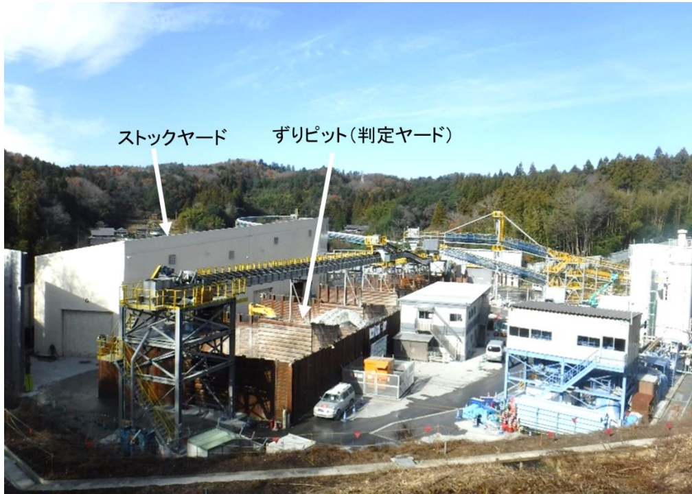
写真 参 3-1 トンネル掘削時の工事施工ヤード内設備配置
