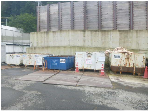
写真4-1-1-13 副産物の分別状況
