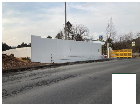
写真4-1-5-2 仮囲いの設置状況
