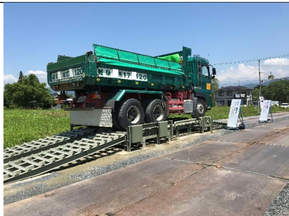
写真4-1-6-5 タイヤ洗浄の実施状況
