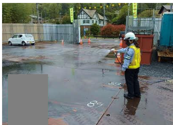
写真4-1-2-3 工事現場の 清掃及び散水状況
