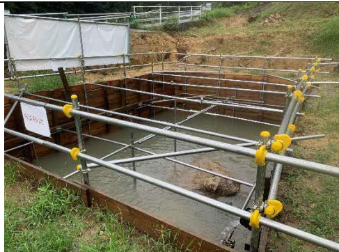
写真4-1-10-5 仮設沈砂池の設置状況
