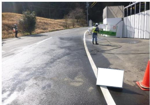
写真4-1-1-15 車両の出入り口の 清掃実施状況
