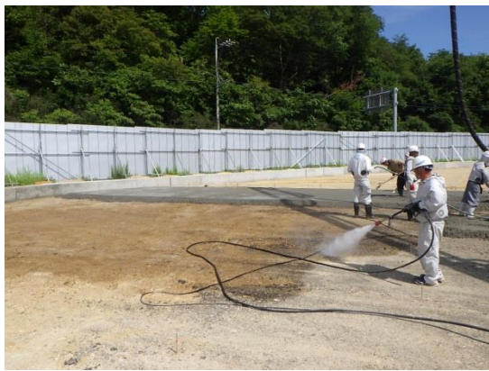
写真4-1-13-3-3 発生土仮置き場の 清掃及び散水の実施状況
