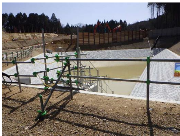
写真4-1-12-5 沈砂池の設置状況
