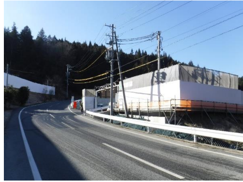
写真4-1-1-2 仮囲いの設置状況
