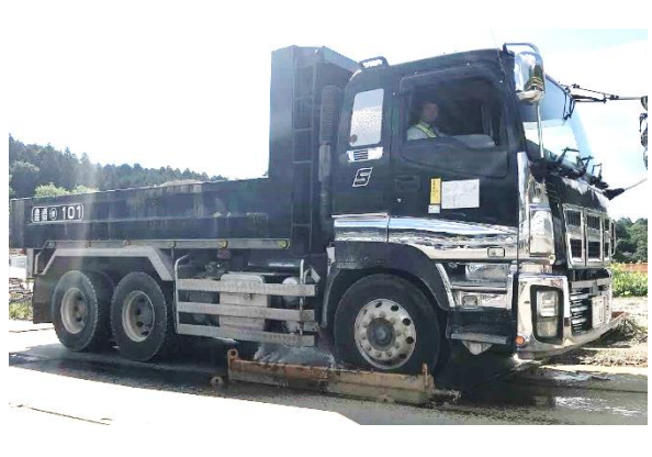
写真4-1-8-10 タイヤ洗浄の実施状況
