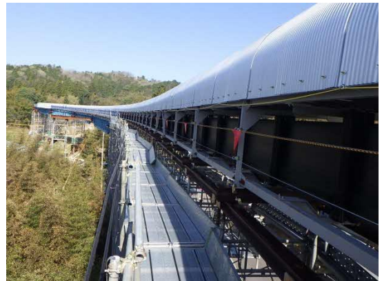
写真4-1-9-10 ベルトコンベアの設置状況
