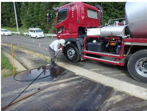
写真4-1-10-8 タイヤ洗浄の実施状況
