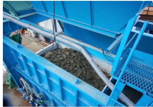
写真4-1-1-12 建設汚泥の脱水処理状況
