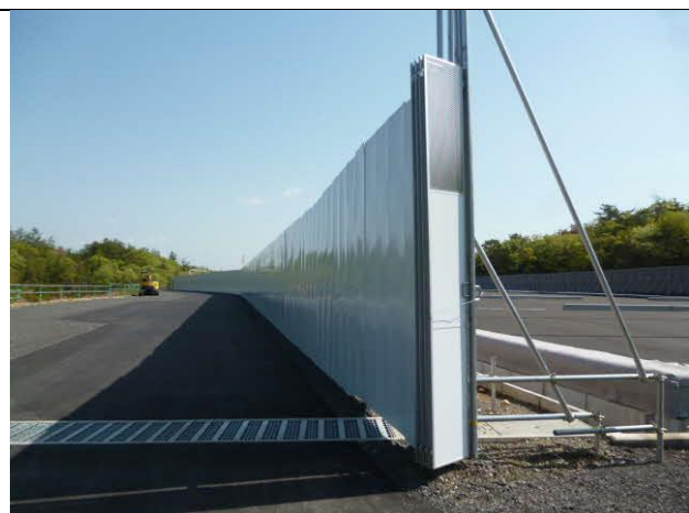
写真4-1-13-4-2 仮囲いの設置状況
