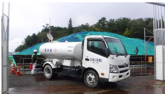
図 参 4-4-1 排水管理 （瑞浪市内土岐町発生土仮置き場）
