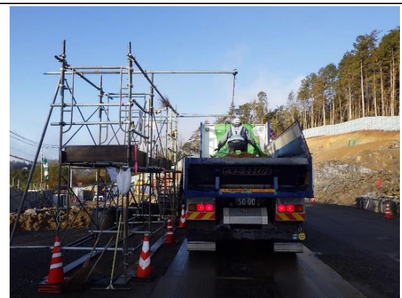
写真4-1-3-9 荷台への防じんシート敷設状況
