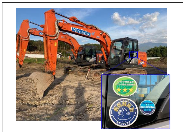
写真4-1-5-1 排出ガス対策型、 低騒音型建設機械の稼働
