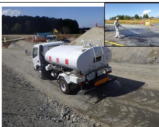
写真4-1-6-4 工事現場の散水の 実施状況
