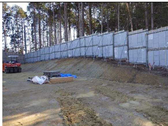
写真4-1-12-2 仮囲いの設置状況
