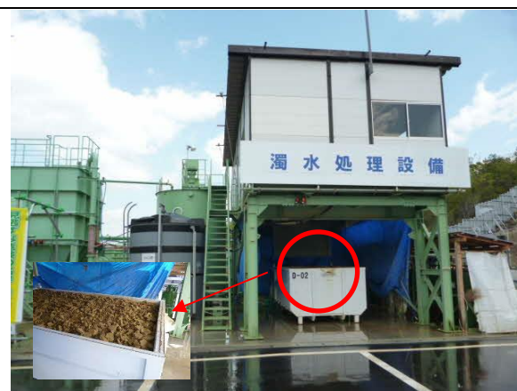
写真4-1-11-10 建設汚泥の脱水処理状況
