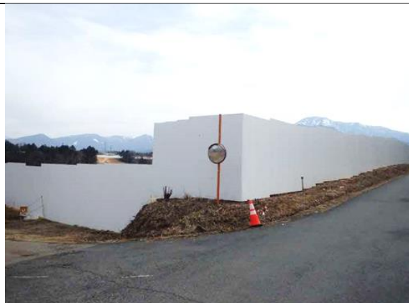
写真4-1-6-2 仮囲いの設置状況
