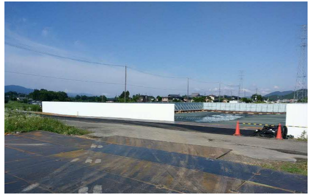
写真4-1-13-2-2 仮囲いの実施状況
