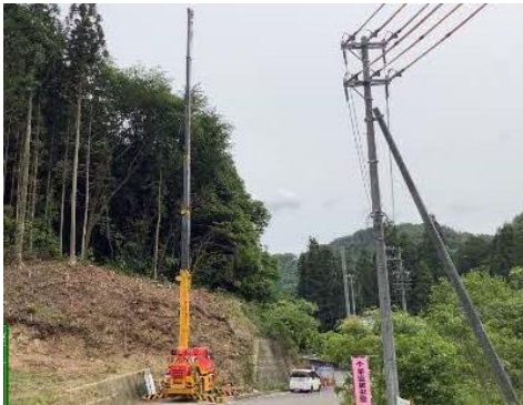
クレーン作業の状況
