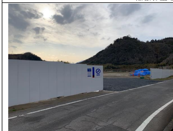
写真4-1-4-2 仮囲いの設置状況
