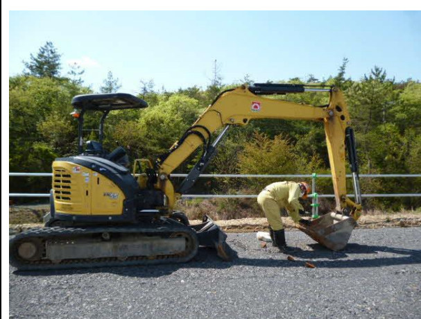
写真4-1-13-4-3 建設機械の点検及び整備 による性能維持の実施状況
