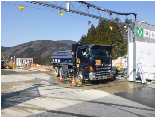
写真4-1-1-11 タイヤ洗浄の実施状況
