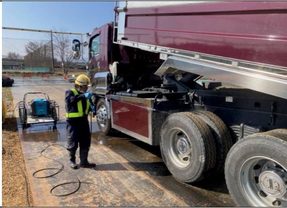
写真4-1-13-2-7 タイヤ洗浄の実施状況
