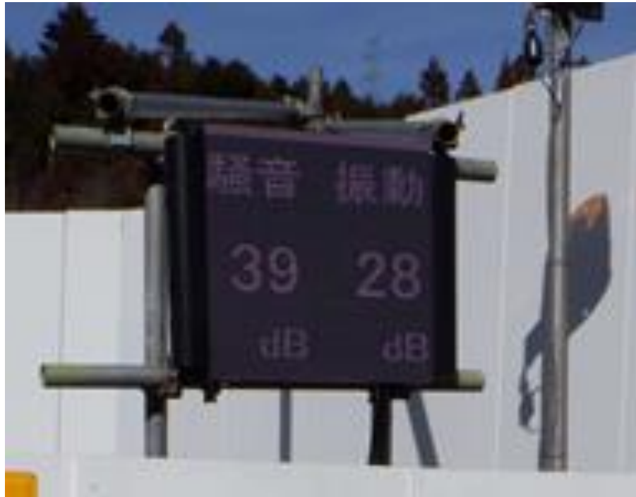
写真 参-2(5)-2 モニター表示例 (05 長島トンネル)
