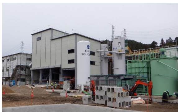
写真4-1-8-3 防音型吹付プラントの設置状況
