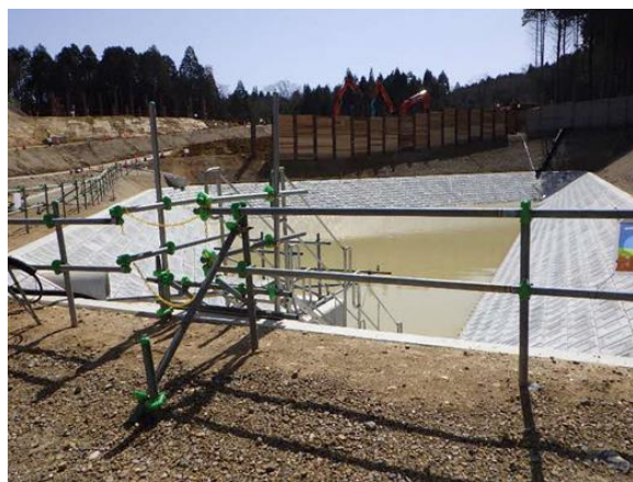
写真4-1-6-5 沈砂池の設置状況
