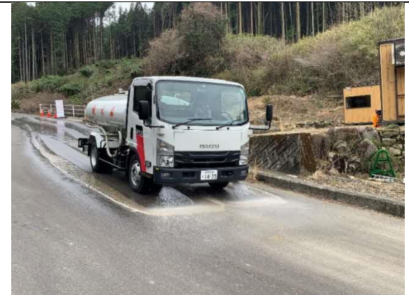
写真4-1-4-4 周辺道路の 清掃及び散水状況
