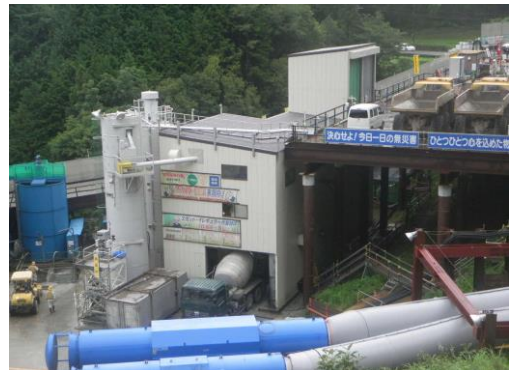
写真4-1-1-4 吹付コンクリートプラント の建屋設置状況
