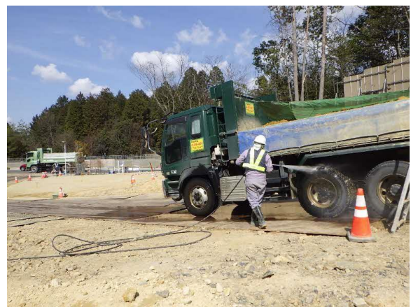
写真4-1-6-6 タイヤ洗浄の実施状況 (外来種の拡大抑制)
