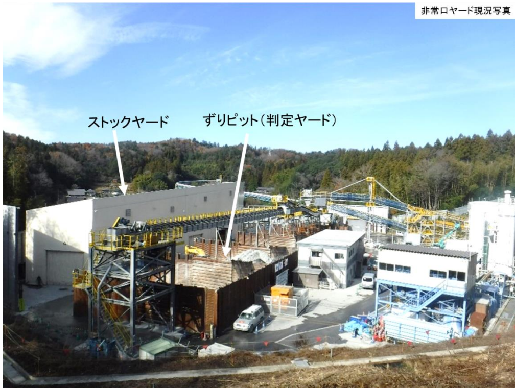
写真 参-3-1 トンネル掘削時の工事施工ヤード内設備配置
