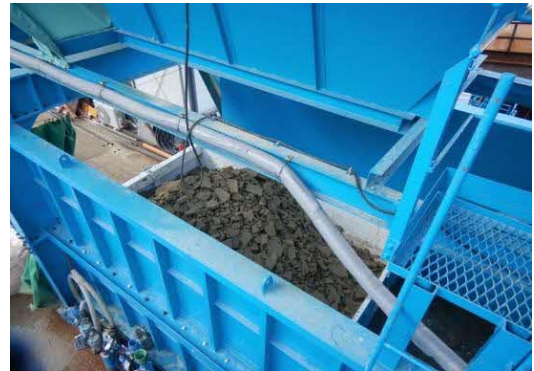
写真4-1-1-12 建設汚泥の脱水処理状況
