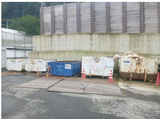
写真4-1-1-13 副産物の分別状況
