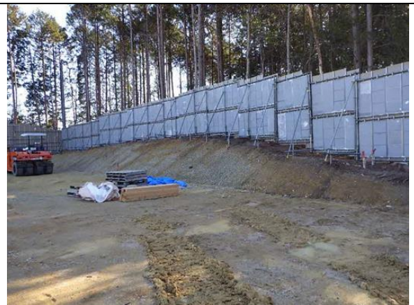
写真4-1-6-2 仮囲いの設置状況
