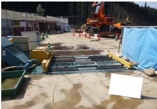
写真4-1-1-11 タイヤ洗浄機の設置状況
