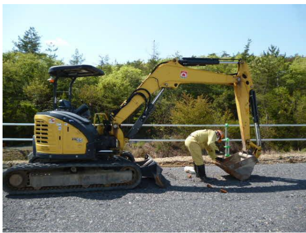
写真4-1-7-3-3 建設機械の点検及び整備による 性能維持の実施状況
