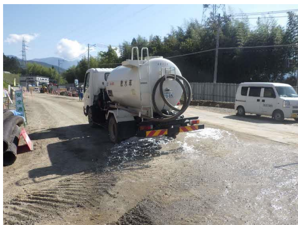
写真4-1-2-5 工事現場の 清掃及び散水状況
