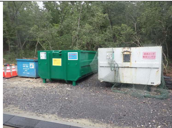
写真4-1-5-11 副産物の分別状況
