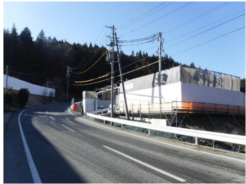
写真4-1-1-2 仮囲いの設置状況
