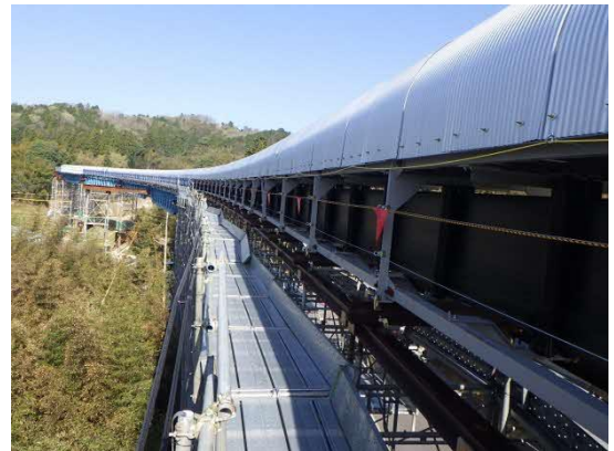
写真4-1-3-10 ベルトコンベアの設置状況
