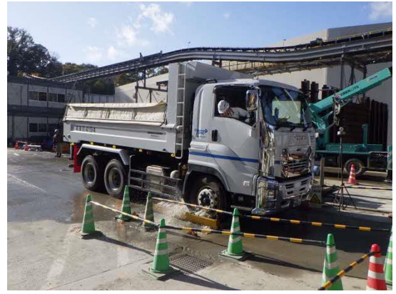
写真4-1-3-8 タイヤ洗浄の実施状況
