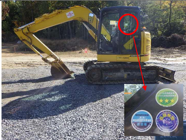
写真4-1-7-3-1 排出ガス対策型、 低騒音型建設機械の使用状況
