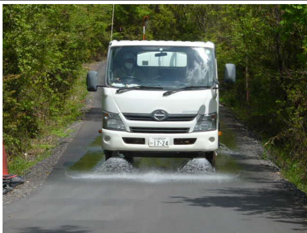
写真4-1-7-3-5 発生土仮置き場の 清掃及び散水の実施状況
