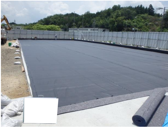
写真4-1-7-2-5 底面における遮水シートの 設置状況
