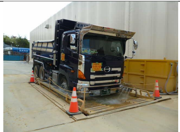
写真4-1-5-12 タイヤ洗浄使用状況
