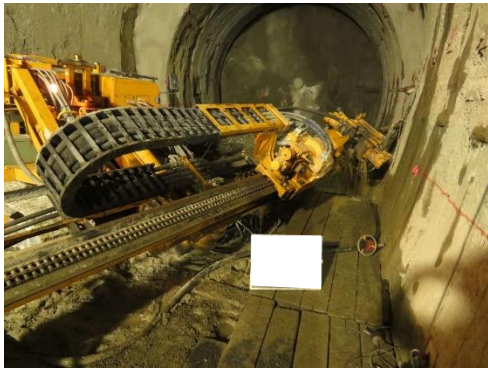
写真4-1-1-9 先進ボーリングによる切羽前方の地質確認状況
