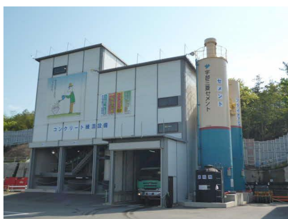
写真4-1-5-4 防音型吹付プラントの設置状況
