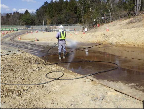
写真4-1-6-7 車両の出入り口の 清掃実施状況
