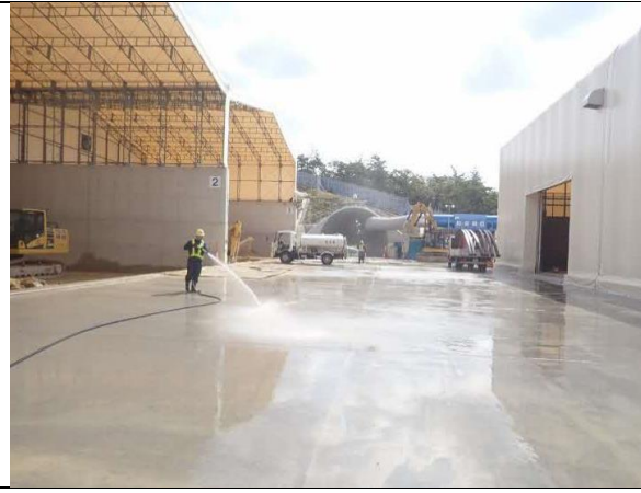
写真4-1-5-7 工事現場の清掃及び散水状況
