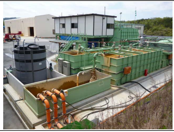
写真4-1-5-8 濁水処理設備設置状況
