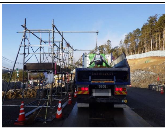
写真4-1-2-8 荷台への防じんシート敷設状況
