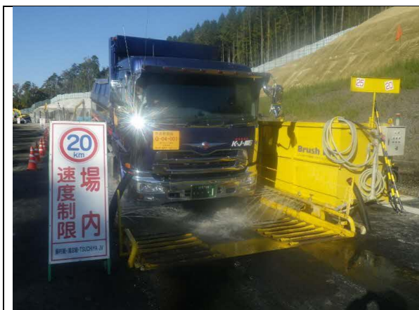
写真4-1-2-7 タイヤ洗浄機の設置状況
