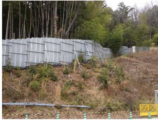
写真4-1-3-2 仮囲いの設置状況
