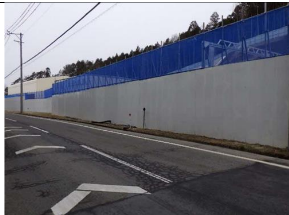
写真4-1-2-2 仮囲いの設置状況
