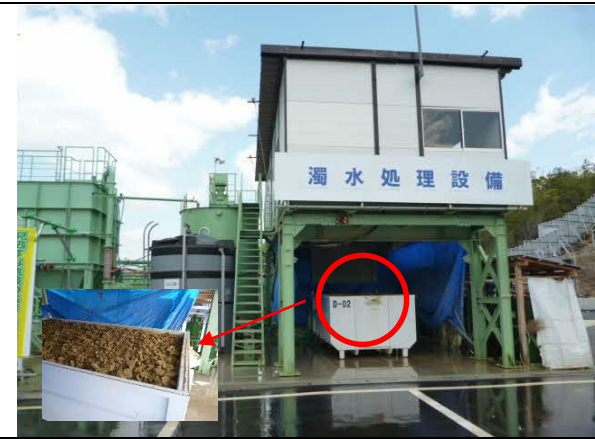
写真4-1-5-10 建設汚泥の脱水処理状況
