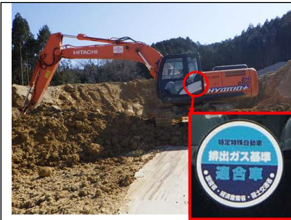
写真4-1-6-1 排出ガス対策型、 低騒音型建設機械の使用状況
