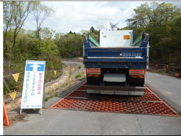
写真4-1-5-9 車両のタイヤ洗浄実施状況 (外来種抑制対策)
