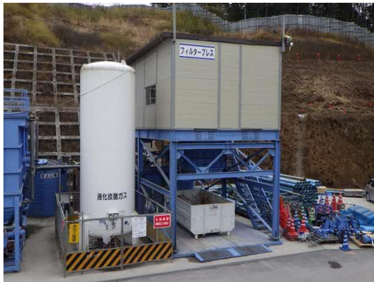
写真4-1-3-9 建設汚泥の脱水処理状況
