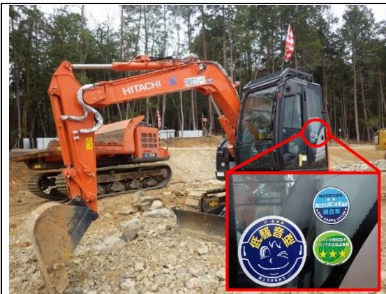
写真4-1-2-1 排出ガス対策型、 低騒音型建設機械の稼働
