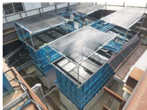
写真4-1-1-8 濁水処理設備の稼働状況
