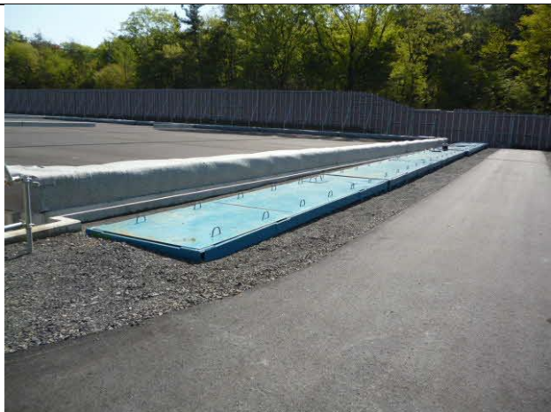
写真4-1-7-3-6 集水タンクの設置状況
