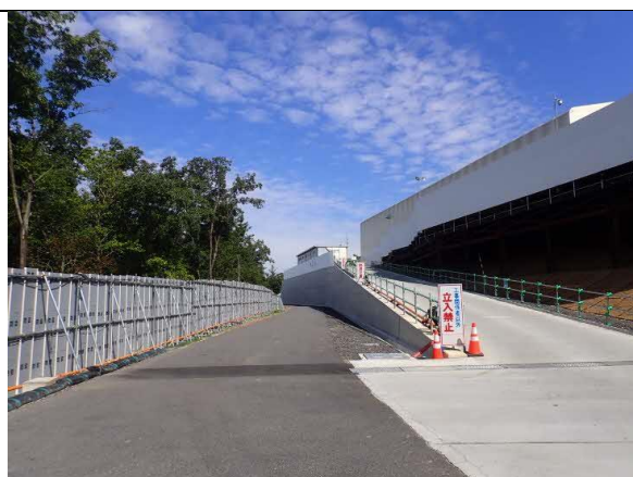
写真4-1-5-2 仮囲いの設置状況
