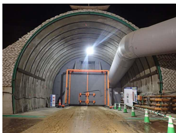
写真4-1-5-3 防音扉の設置状況
