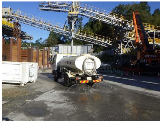
写真4-1-3-6 工事現場の 清掃及び散水状況
