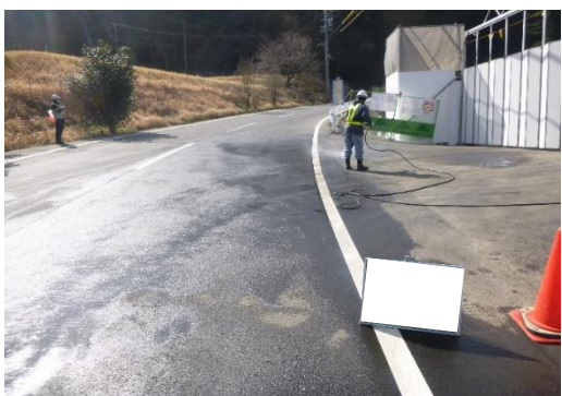
写真4-1-1-15 車両の出入り口の清掃実施状況
