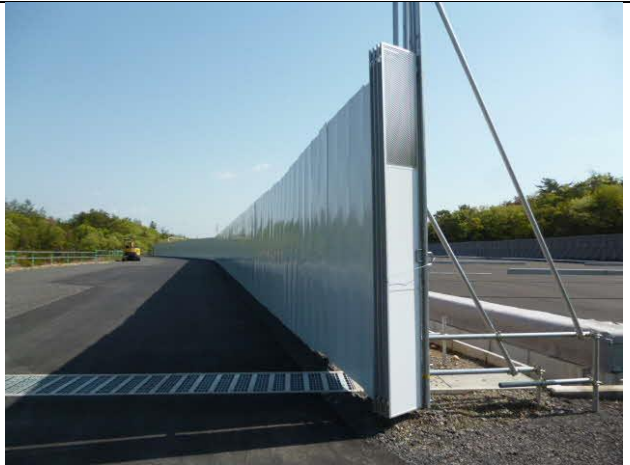
写真4-1-7-3-2 仮囲いの設置状況
