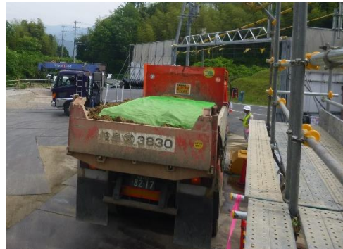
写真4-1-1-14 荷台への防じんシート敷設状況
