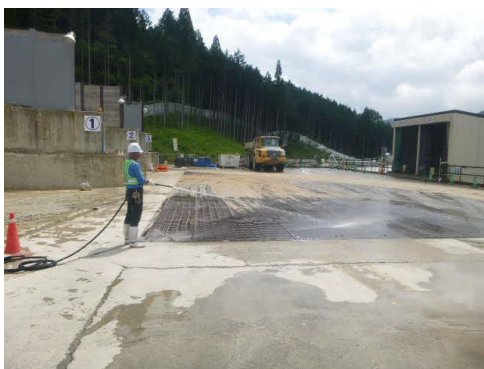
写真4-1-1-7 工事現場の 清掃及び散水状況
