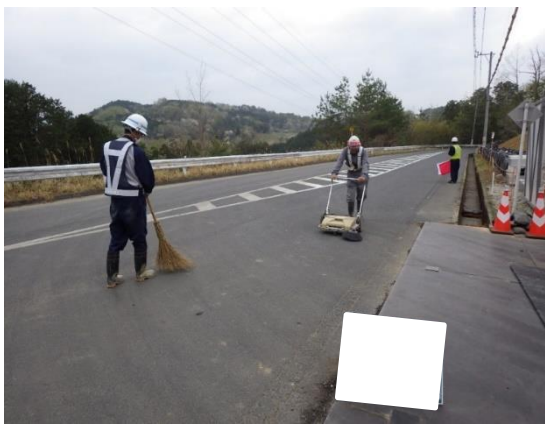
写真4-1-2-9 車両の出入り口の 清掃実施状況
