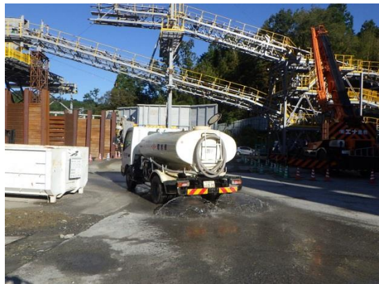
写真4-1-3-6 工事現場の 清掃及び散水状況
