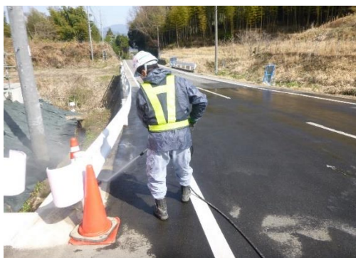
写真4-1-1-7 工事現場の 清掃及び散水状況
