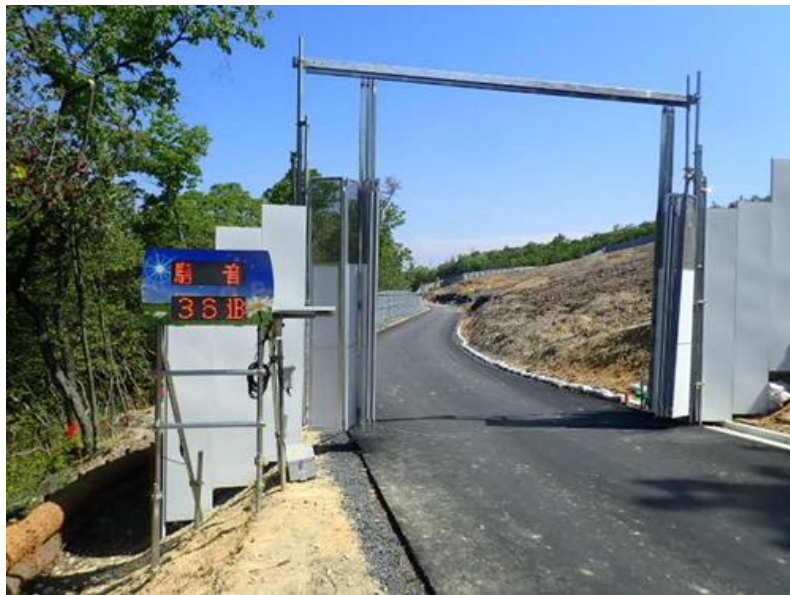
写真 参-2(4) モニター表示例 (04 大森非常口)
