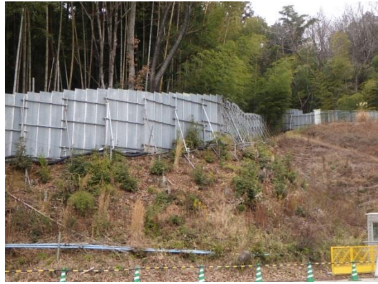
写真4-1-3-2 仮囲いの設置状況
