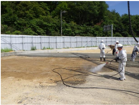
写真4-1-5-2-3 発生土仮置き場の 清掃及び散水の実施状況
