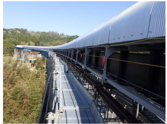
写真4-1-3-10 ベルトコンベアの設置状況
