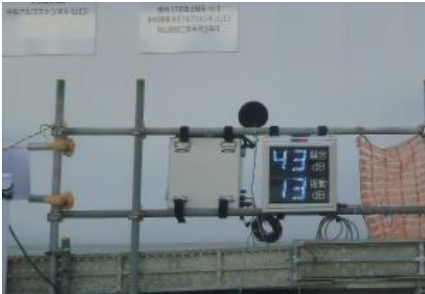
写真 参-2(1) モニター表示例 (01 山口非常口)
