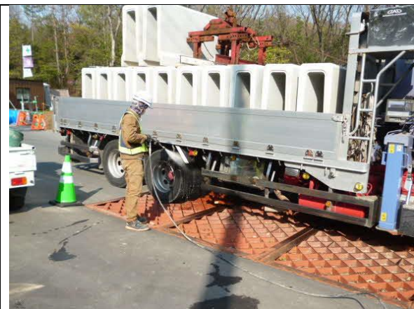
写真4-1-4-7 タイヤ洗浄の実施状況 (外来種の拡大抑制)
