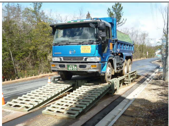
写真4-1-4-8 タイヤ洗浄（乾式）の 実施状況（粉じん等の低減）
