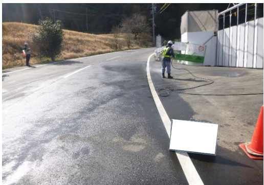
写真4-1-1-15 車両の出入り口の清掃実施状況
