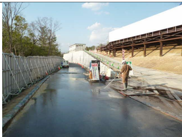
写真4-1-4-9 車両の出入り口の 清掃実施状況
