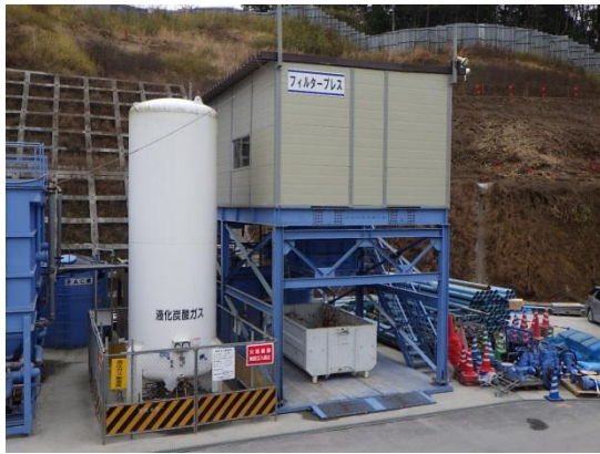
写真4-1-3-9 建設汚泥の脱水処理状況
