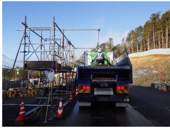
写真4-1-2-8 荷台への防塵シート敷設状況
