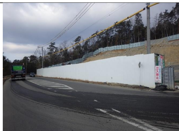
写真4-1-2-2 仮囲いの設置状況
