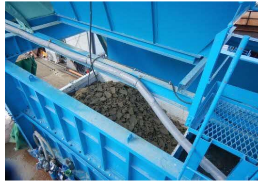
写真4-1-1-12 建設汚泥の脱水処理状況
