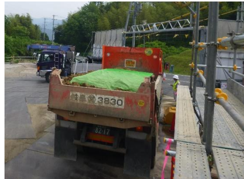
写真4-1-1-14 荷台への防塵シート敷設状況
