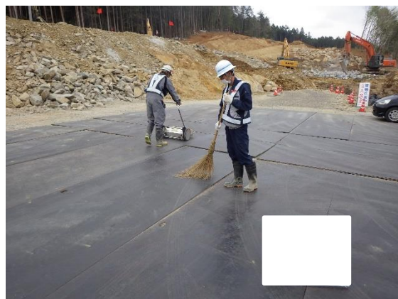
写真4-1-2-5 工事現場の 清掃及び散水状況
