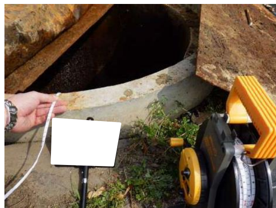
写真4-1-2-6 地下水等の監視状況
