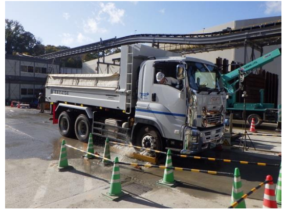
写真4-1-3-8 タイヤ洗浄の実施状況
