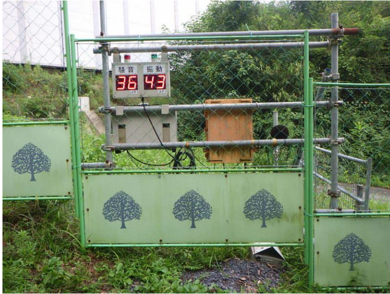
写真 参-2(3) モニター表示例 (03 南垣外非常口)
