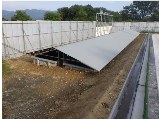
写真4-1-5-2-4 区分土への遮水シート等の 敷設状況
