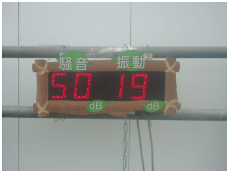
写真 参-2(2) モニター表示例 (02 瀬戸非常口)
