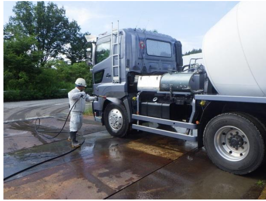
写真4-1-5-2-8 タイヤ洗浄の実施状況
