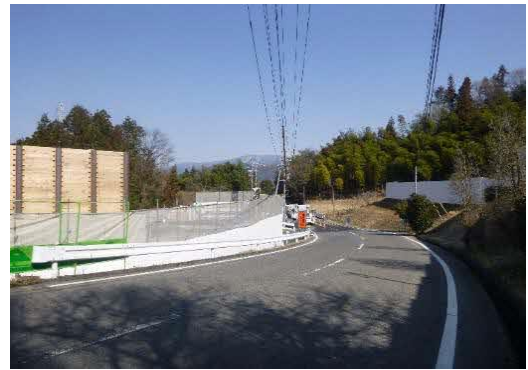
写真4-1-1-2 仮囲いの設置状況
