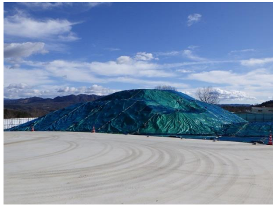
写真4-1-5-2-4 区分土への遮水シート等の 敷設状況
