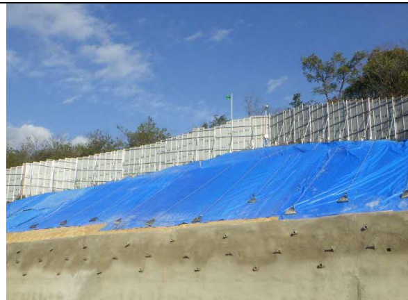
写真4-1-4-2 仮囲いの設置状況
