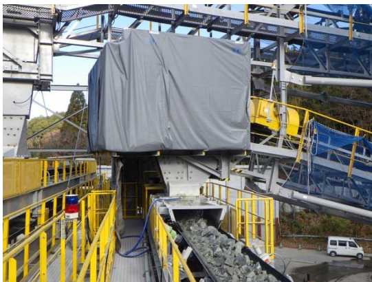
写真4-1-3-3 ベルトコンベア乗換部の 防音シートの設置状況
