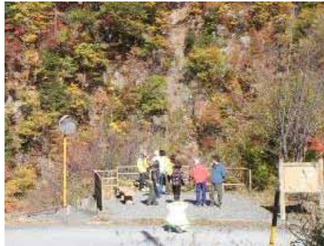
林道東俣線:現地の状況
