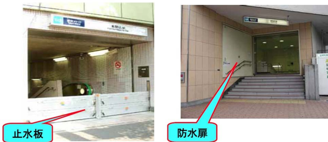
浸水対策設備
