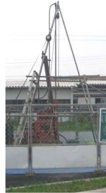
ボーリング調査の状況
