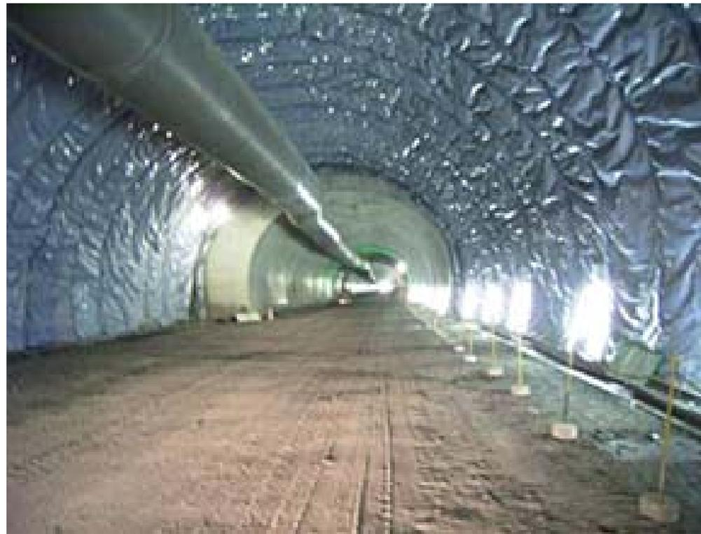
防水シートの施工例(一般国道191号線 萩・三隅道路)
