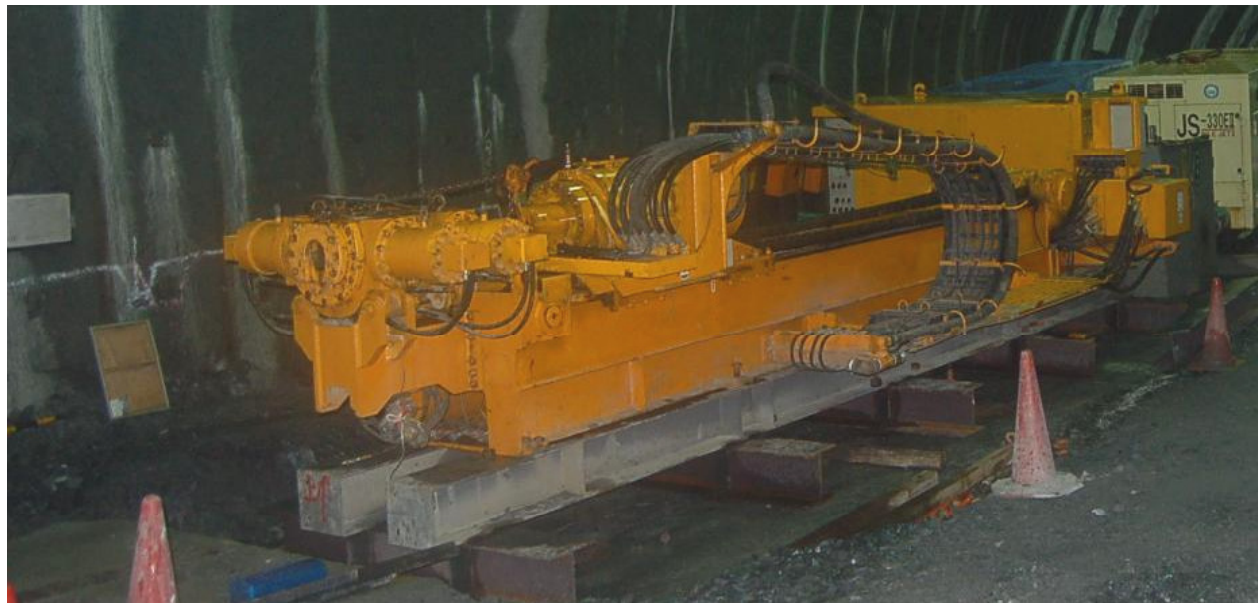
写真 先進ボーリングマシン
