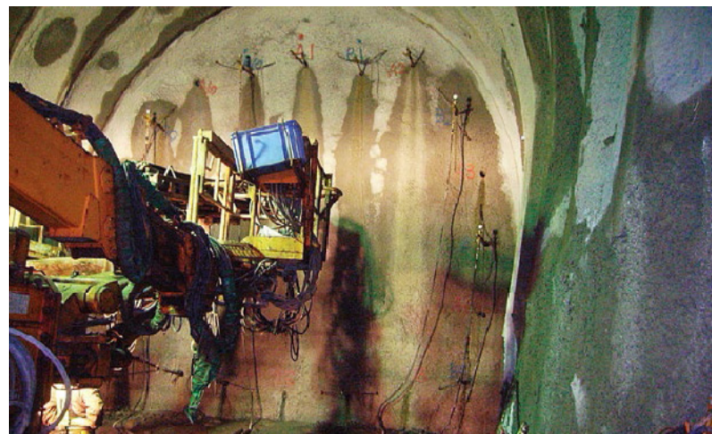
写真 薬液注入工の施工例
