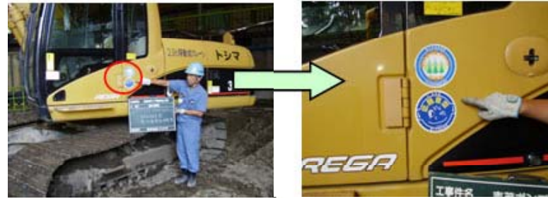
・排出ガス対策型、低騒音型、低振動型建設機械の使用
