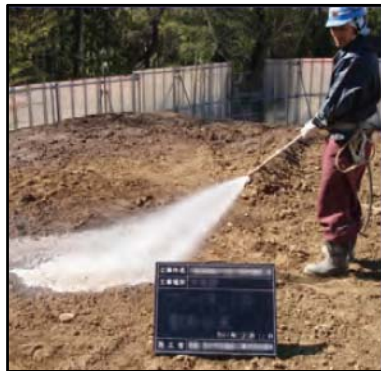
・工事現場の清掃及び散水
