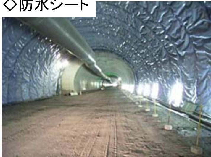
防水シートの施工例(一般国道191号線 萩・三隅道路) (国土交通省 中国地方整備局 山口河川国道事務所ホームページより抜粋)
