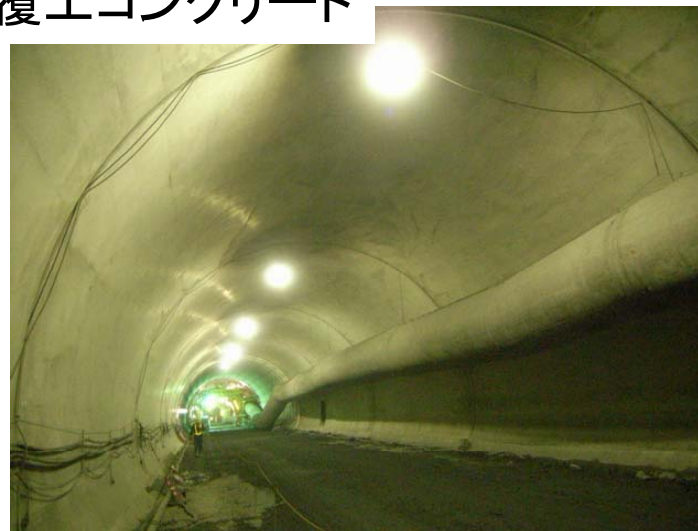
覆エコンクリートの施工例(一般県道 常神三方線 神子トンネル) (福井県 敦賀土木事務所 道路改良主要事業 ホームページより抜粋)
