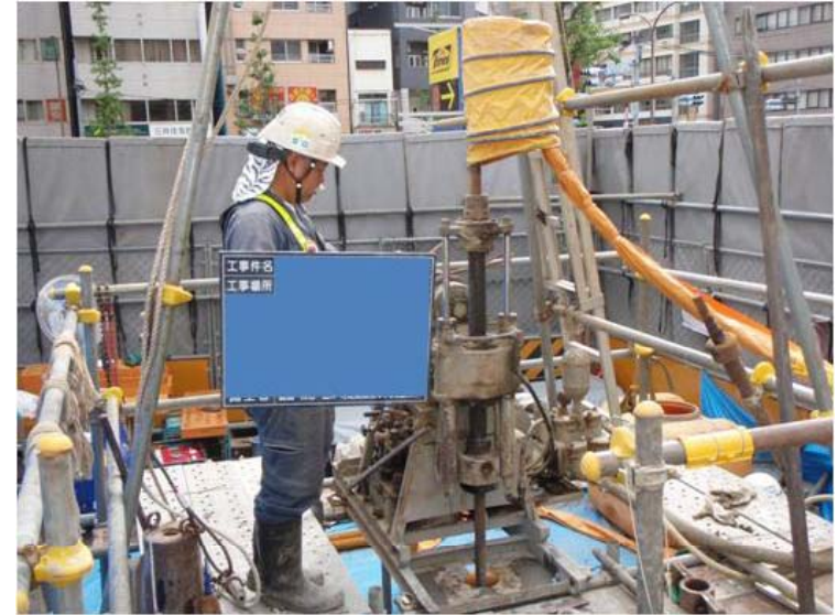
ボーリング調査の様子
