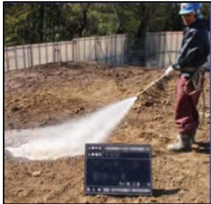
・工事現場の清掃及び散水
