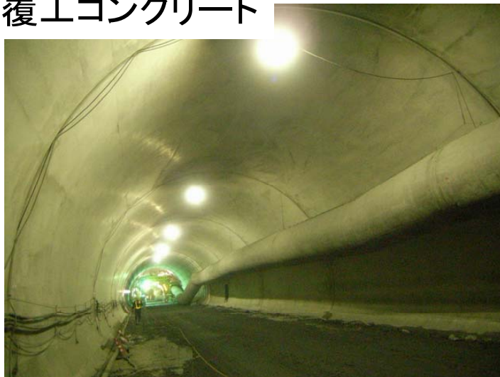
覆エコンクリートの施工例(一般県道 常神三方線 神子トンネル) (福井県 敦賀土木事務所 道路改良主要事業 ホームページより抜粋)
