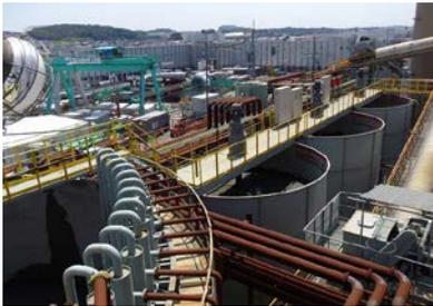
シールド発進後の、掘削土処理に必要なプラントを設置します。
