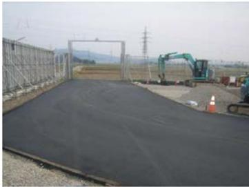
車両の走行路となる、アスファルト舗装を構築します。
