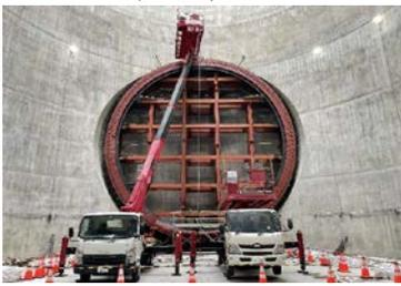
立坑内に、昇降設備や発進坑口を設置します。
