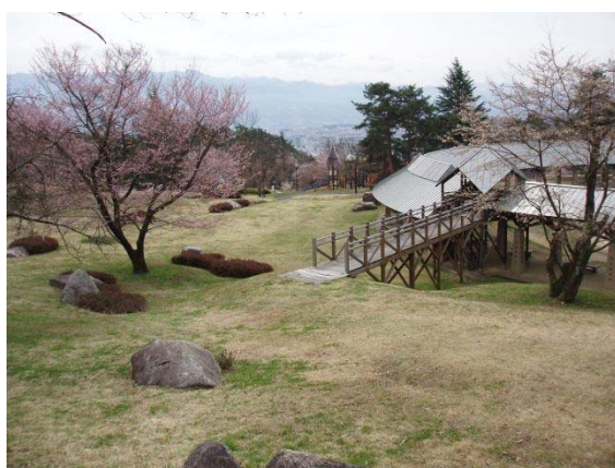
野外施設（風の広場）の状況
