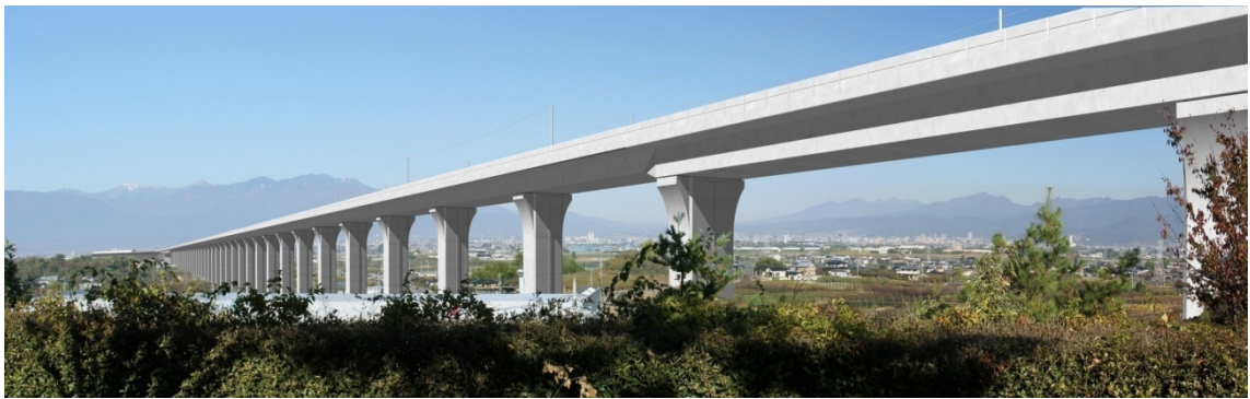
図 16-1-2-6 第1中央自動車道架道橋
