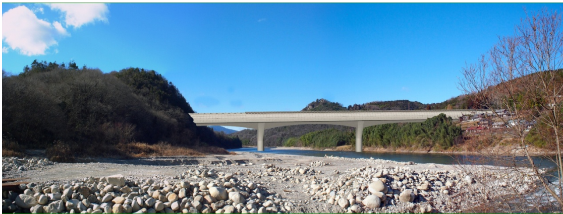
图 16-1-2-14 第2木曾川桥梁
