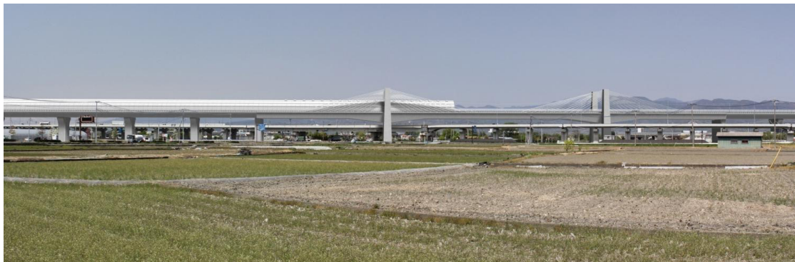
图 16-1-2-8 新山梨環状道路架道橋
