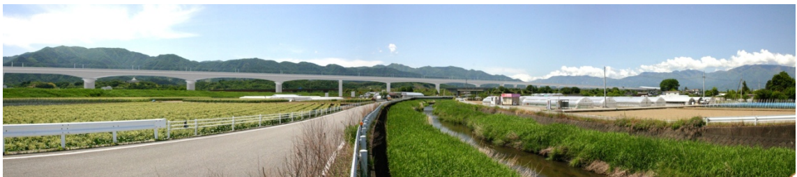
図 16-1-2-7 笛吹川・濁川橋梁及び第2中央自動車道架道橋
