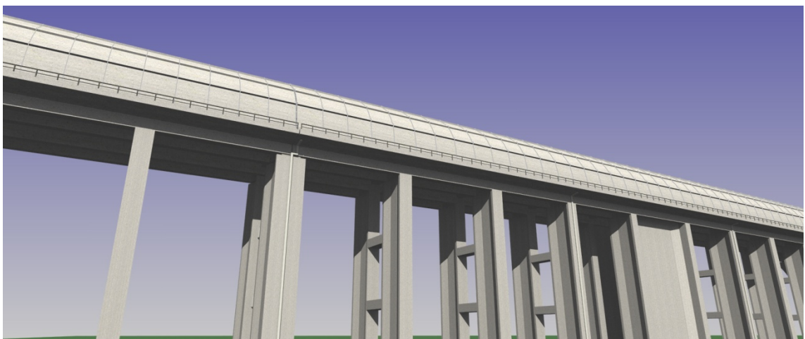
図 16-1-2-2 新形式高架橋（防音防災フード部）
