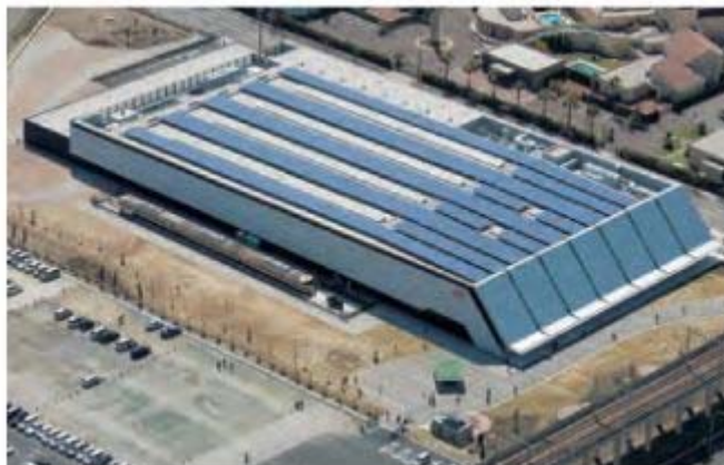
図 19-3-8 リニア・鉄道館（太陽光発電システム）
