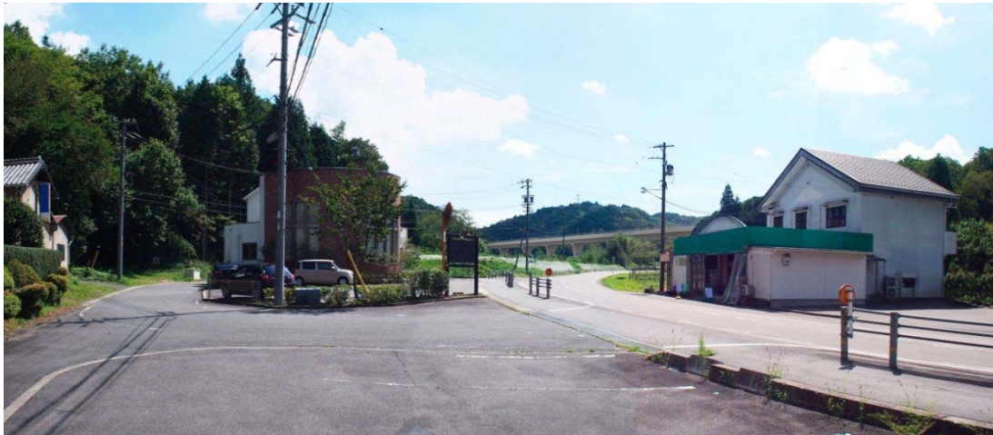
図 17-1-15 久々利高架橋
