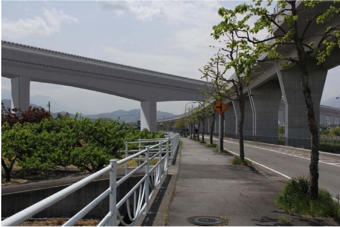
图 17-1-10 中部横断道架道橋
