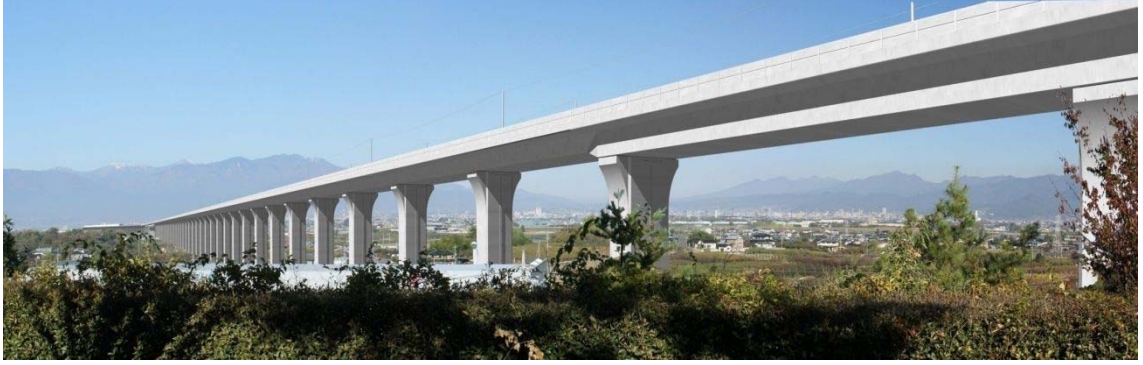
图 17-1-6 第 1 中央自動車道架道橋
