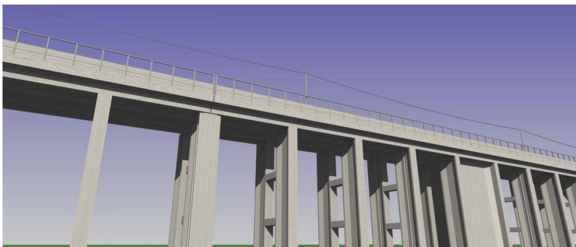
図 17-1-3 新形式高架橋（防音壁部）
