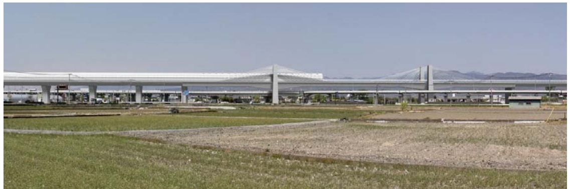
图 17-1-8 新山梨環状道路架道橋
