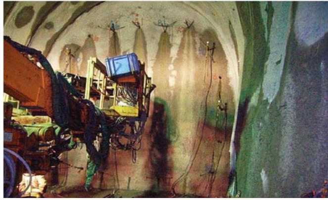
図 7-4-3 薬液注入工の施工例
