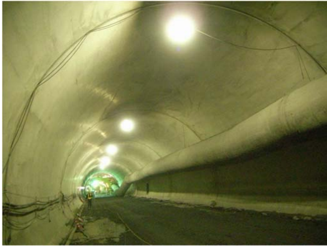
図 7-4-6 覆エコンクリートの施工例（一般県道 常神三方線 神子トンネル） （福井県 敦賀土木事務所 道路改良主要事業 ホームページより抜粋）
