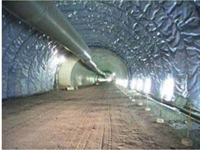
図 7-4-5 防水シートの施工例（一般国道 191 号線 萩・三隅道路） （国土交通省 中国地方整備局 山口河川国道事務所ホームページより抜粋）
