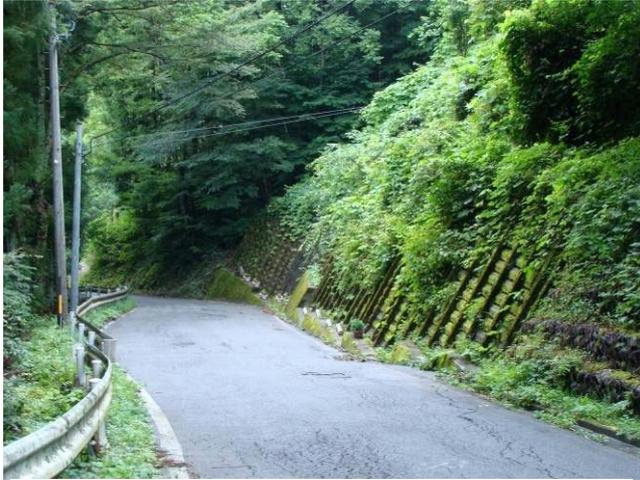
写真 9-1-5-3 上蔵集落西方の村道沿いの地すべり地。路面は変状が多く、井桁擁壁が組まれている。
