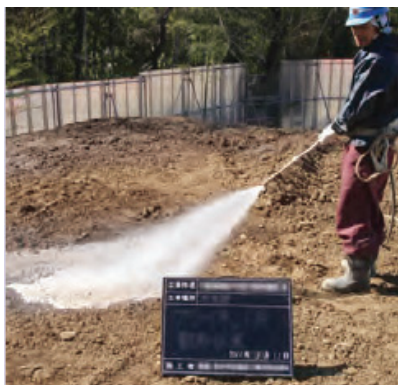
工事現場における散水の例
