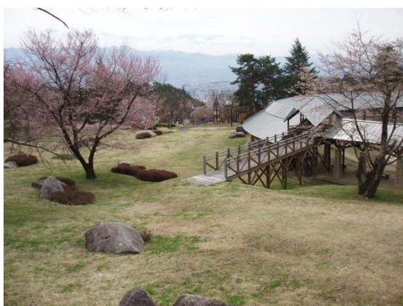
野外施設（風の広場）の状況
