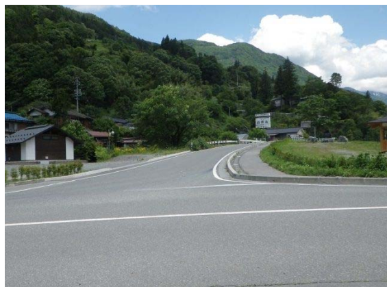
県道 253 号の始点の状況
