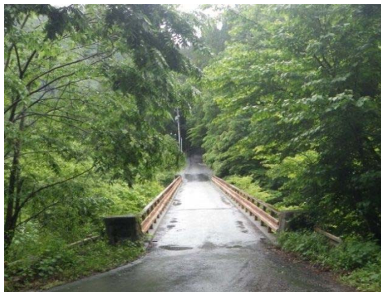
終点手前の小河内沢川に架かる橋梁の状況
