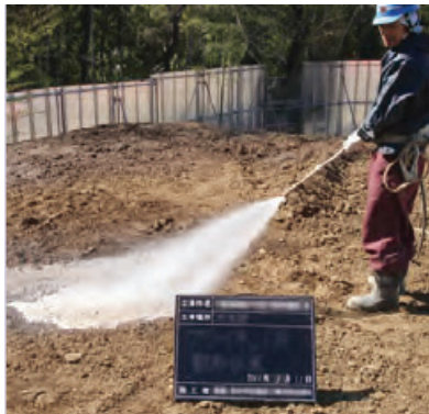
工事現場における散水の例
