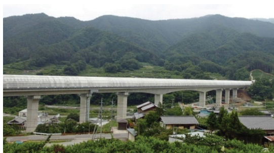
防音防災フードの設置の例
