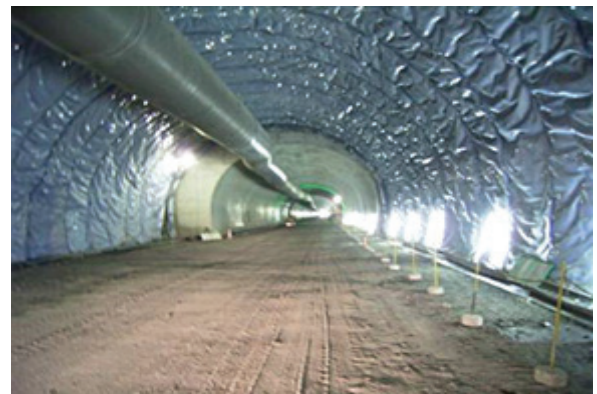
適切な構造の採用（防水シート）の例
