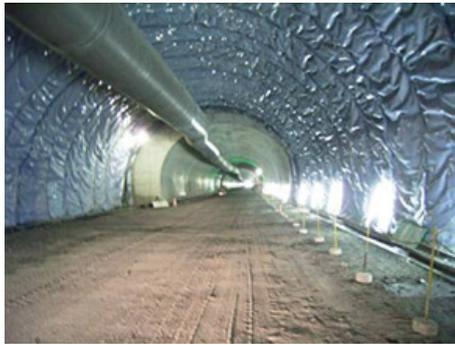
適切な構造の採用（防水シート）の例
