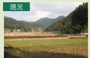
山梨リニア実験線での活用例(山梨県都留市) (建設発生土を有効利用し谷地を埋め立てて農地として活用)
