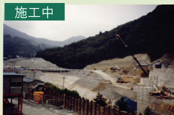
山梨リニア実験線での活用例(山梨県都留市) (建設発生土を有効利用し谷地を埋め立てて農地として活用)
