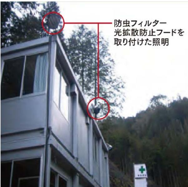
図 16-2-6 照明の漏れ出しの抑制の例
