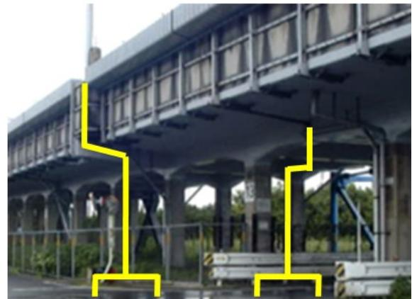
図 4-1-5 鉄道施設（高架橋）における接地例
