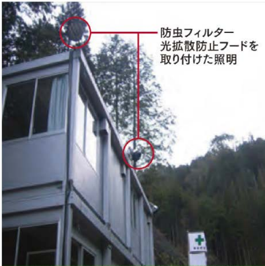
図 14-5-7 照明の漏れ出しの抑制の例
